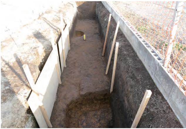
調査全景 A区 (西方向から)
