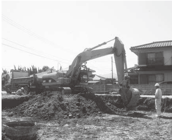
I・II地区表土除去
