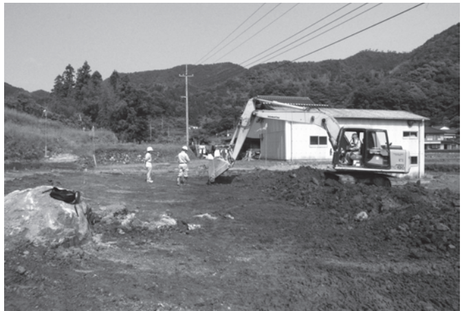
重機による表土除去
