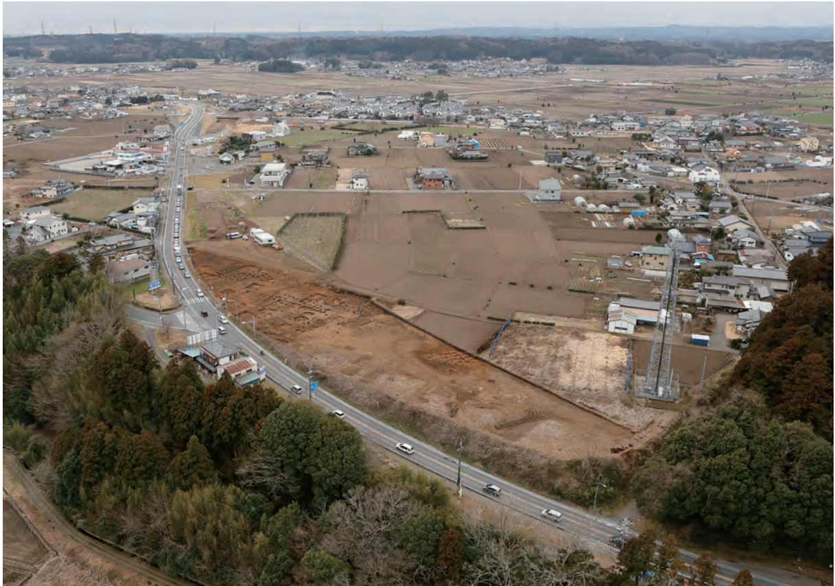
平成28年度調査区全景（北東上空から）
