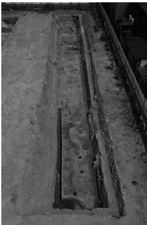
6. 2区遺構完掘 (西から)
