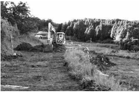
重機による表土除去作業
