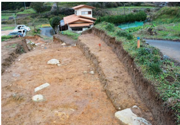
5 4地区南側調査区状況（南から）
