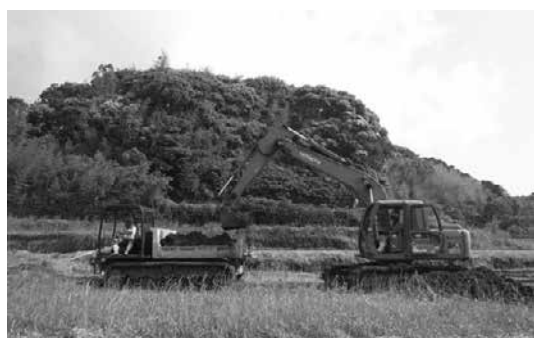
重機による表土除去（本郷遺跡）
