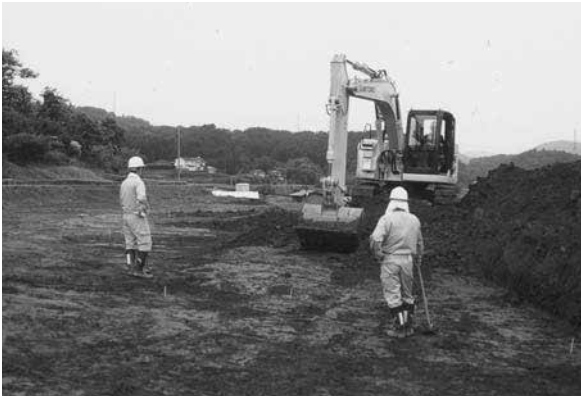
重機による表土除去作業
