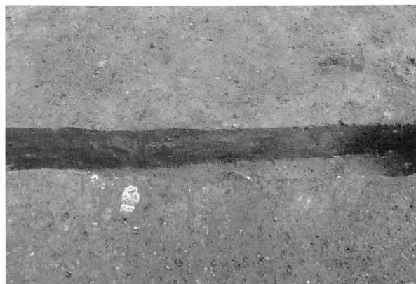
4. VF-12断面 SW→
