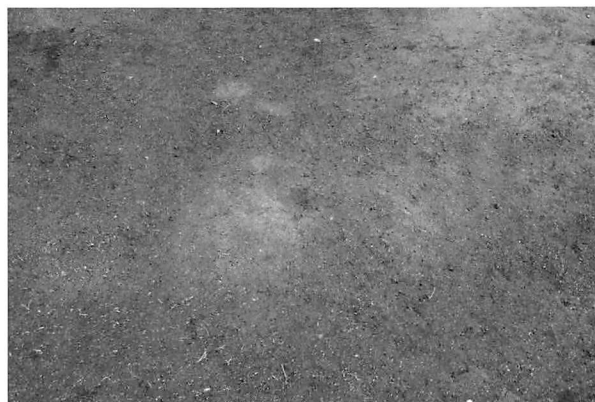
3. VF-06検出 SW→
