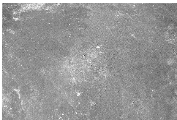
7. III F-42検出(W→)
