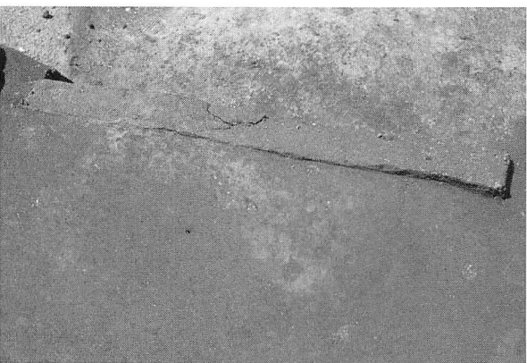
7. III F-35検出(W→)
