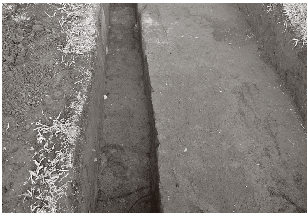
S D 9 確認状況 (1) (西から) 掘削前
