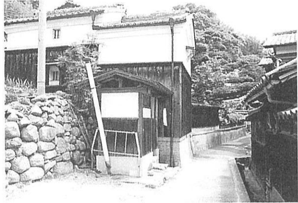
31. 岡田家土蔵の外観
