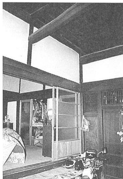
28. 土間入口まわり
