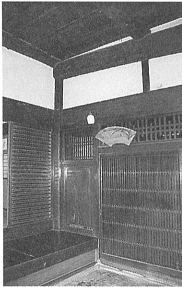
58. 土間入口まわり
