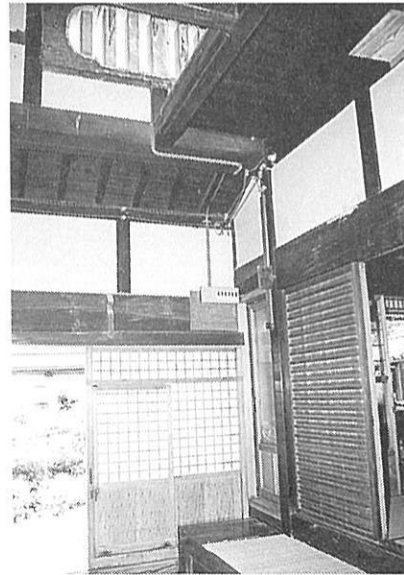
35. 土間上部の梁組
