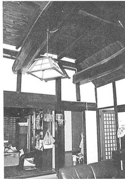
21. 土間上部の梁組
