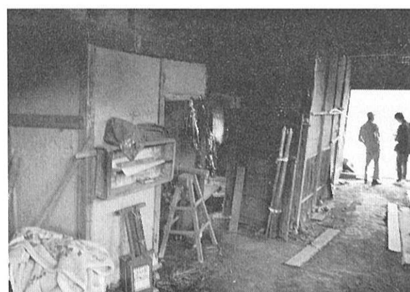
写真4 寒天小屋 内部
