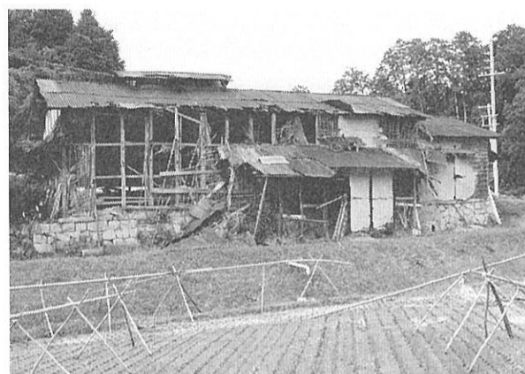
写真2 寒天小屋 裏から
