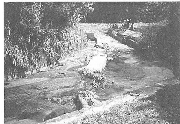
下ン代水路の井堰(塩田川)
