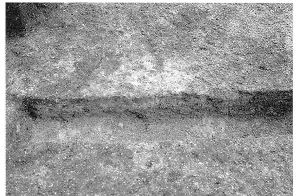
8. VF-10断面 (W→)
