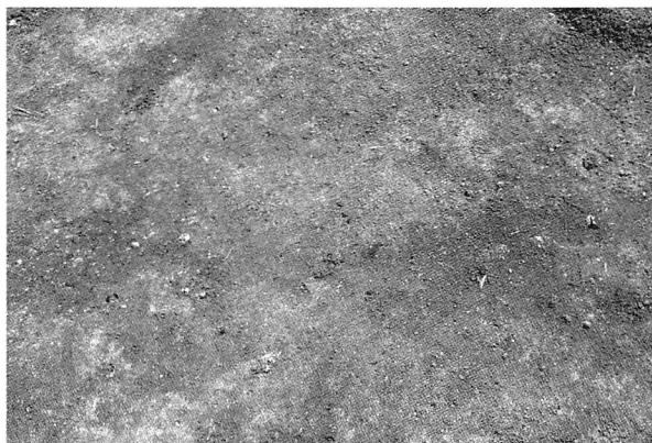
7. VF-26検出 (SW→)
