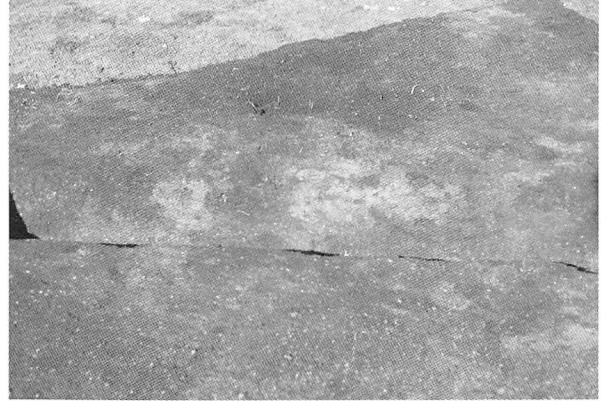
2. VF-34断面 (W→)
