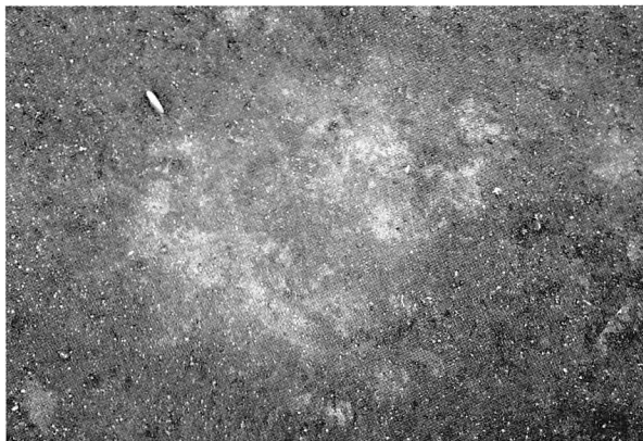
3. VF-24検出 (SW→)
