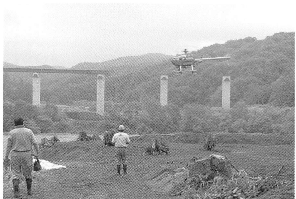
6. 平成20年度空中撮影状況 (NW→)
