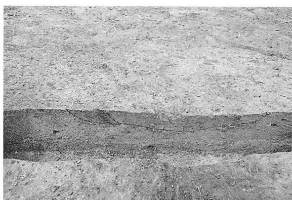
4. VF-15断面 E→
