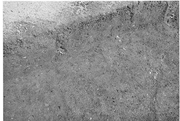
4. VF-11断面 W→
