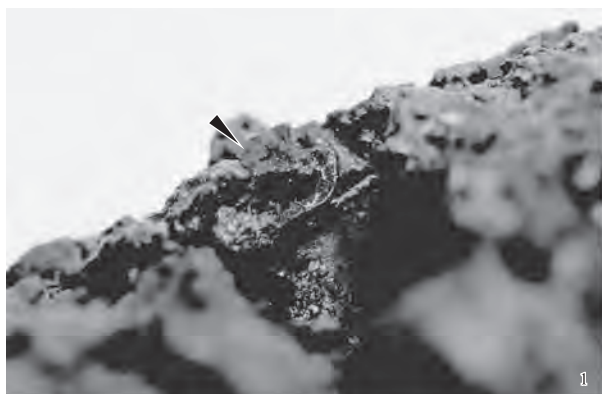
鉄線の断面形状：錆膨れがあるが、三角形状であることがわかる。
