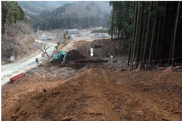
3. トレンチ1 遠景（北から） *写真奥中央に松葉板碑群
