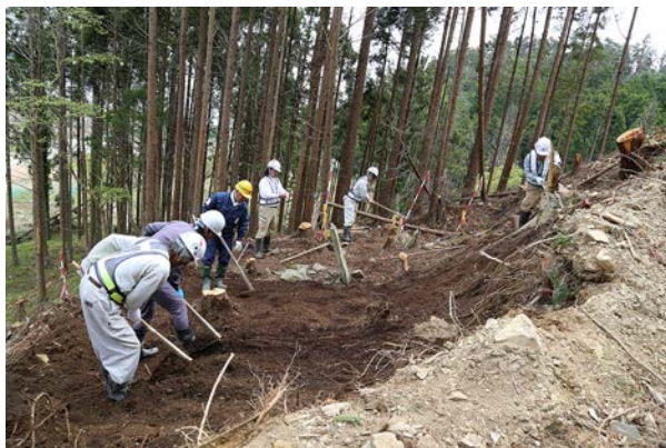
南西平坦面の表土除去状況（西から）
