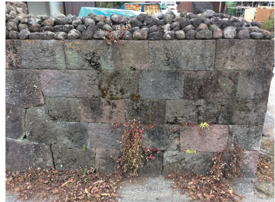
第97図 切り込み矧ぎ布積み
