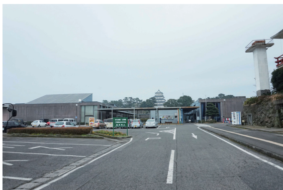
第51図 二ノ丸内部 北から
