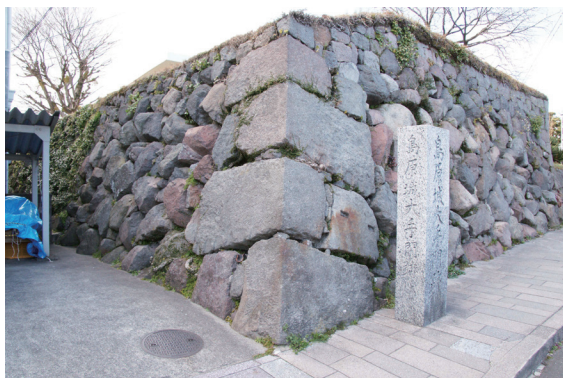
第 57 図 外郭線石垣隅角部 80078008
