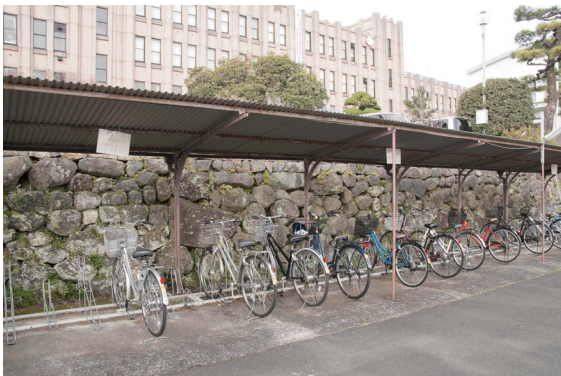
第55図 三ノ丸石垣4004(島原高校駐輪場)
