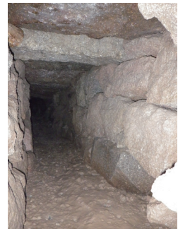
第26図 暗渠内部（南から）
