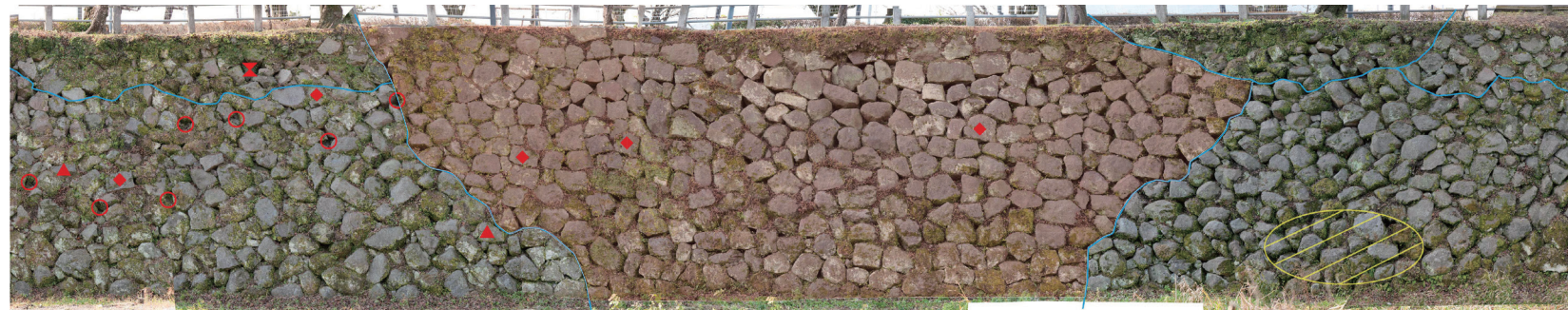
石垣 3010 の天保12年(1829)修復推定箇所
