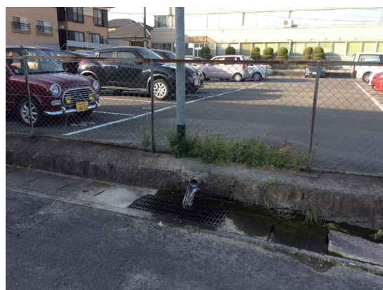
第 90 図 調査地点⑮の排水口
