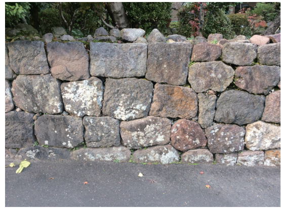
第95図 打ち込み剥ぎ布積み
