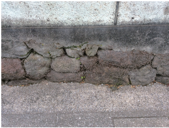
第94図 野面積み乱積み
