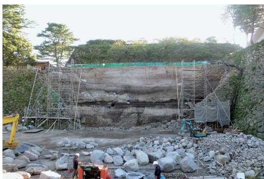
第9図 石垣解体状況（西から）
