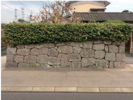
第96図 打ち込み剥ぎ乱積み
