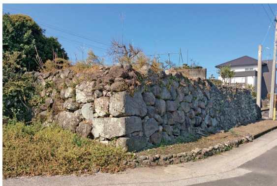
第 59 図 外郭線石垣 5018～5020 (櫓台)
