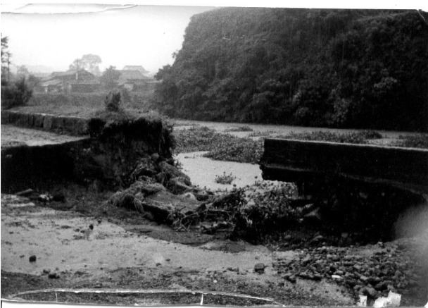
19 南堀端道路法務局前 (昭和 32 年水害時・島原市所蔵) 【昭和 32 年 (1957)】
