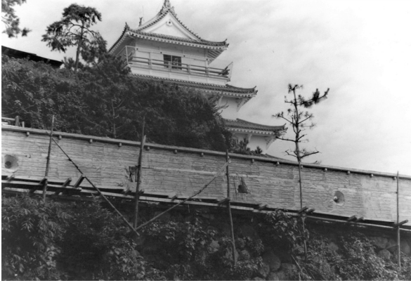
35 模擬塀建設 (肥前島原松平文庫所蔵) 【昭和40年(1965)頃】
