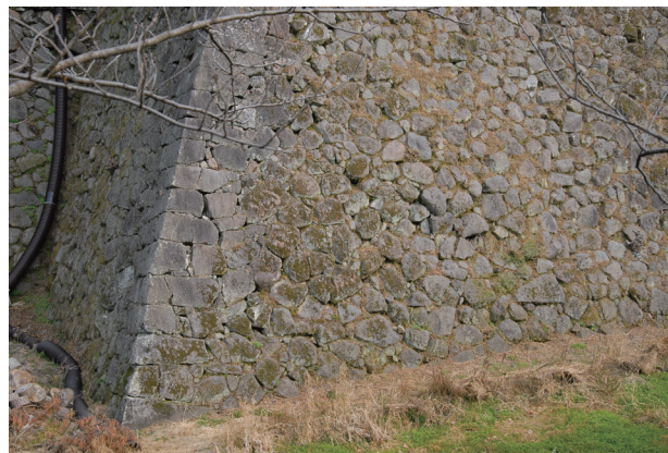
No.1404 石垣状況
