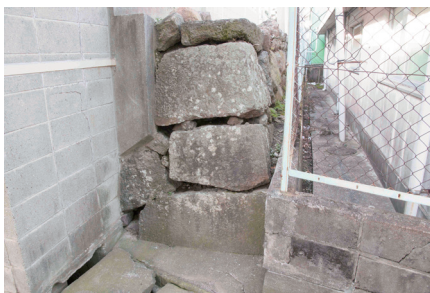
外周石垣 (第一小学校プール西側)
