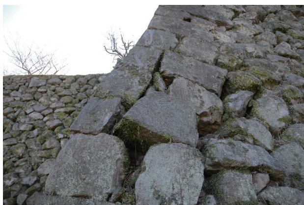
No. 1424 石垣状況
