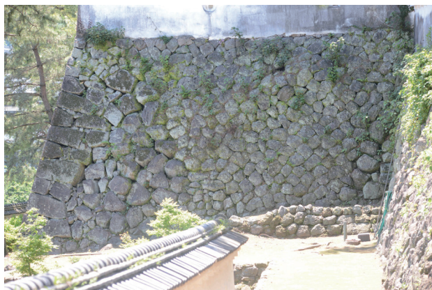
No. 1221 石垣状況
