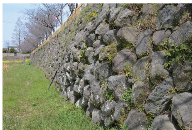
No. 3005 石垣状況
