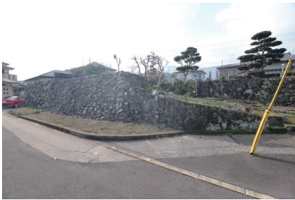
外塁線東側櫓台石垣
