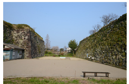
廊下橋架橋部分
