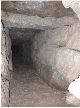
石組水路内部
