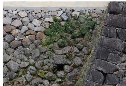
外周石垣西面（No. 2405 石垣）吐水口
