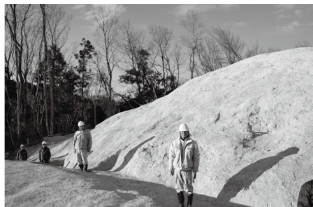
3. 平場 A-6 西側の斜面周辺の状況 (南から撮影)
