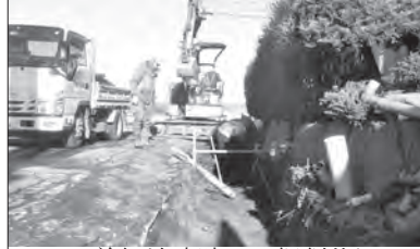
曾根城遺跡12 掘削状況
