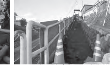
岩村田遺跡群452 掘削状況
