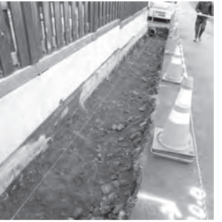
195-4 松原遺跡3 掘削状況
