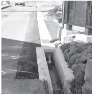
195-2 金井遺跡2 施工状況
