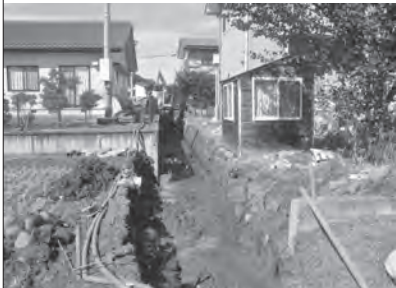
大堀遺跡4・大門下遺跡10 掘削状況
