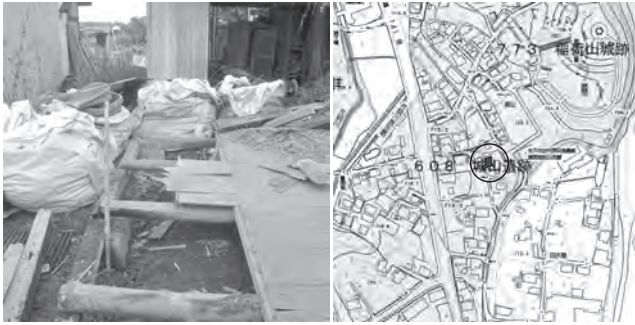
186 城山遺跡3 稲荷山城跡9 施工状況・位置図
