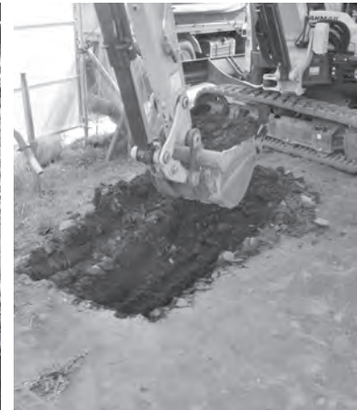
浄化槽設置箇所 掘削状況
