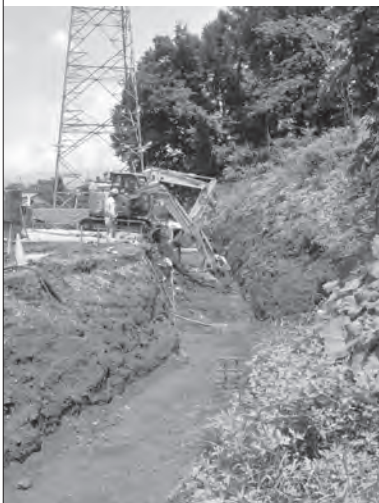
丸山遺跡4 掘削状況
