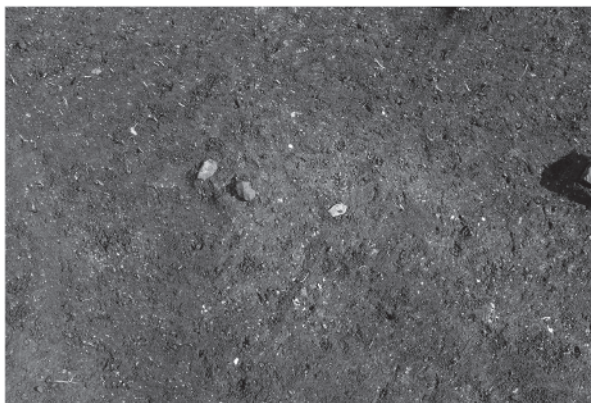
7. VF-25検出 SW→
