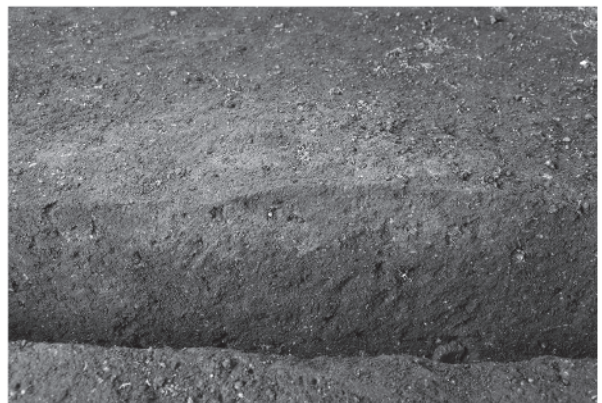
8. VF-17断面 SW→
