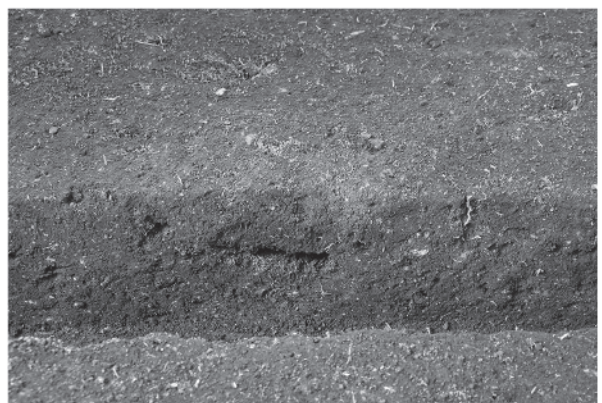
8. VF-33断面 SW→
