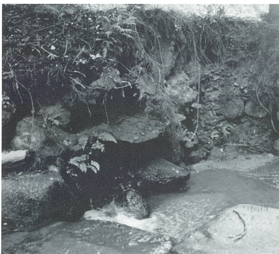
写真6 西側水門遺構の南側端部（南より）
