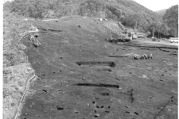
2. H16 年度調査区 V 層上面検出 (NE→)
