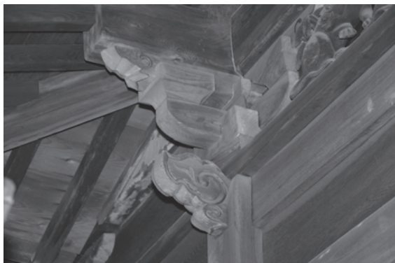
図 825 普賢院本堂北部隅柱頭貫木鼻
