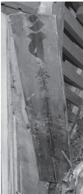
隅木打ち付け
