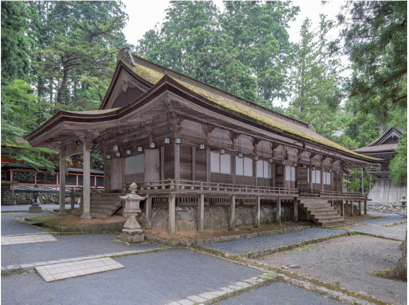
壇上加藍山王院拝殿 正側面
