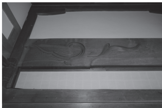
図 705 宝城院客殿板敷の間虹梁形飛貫
