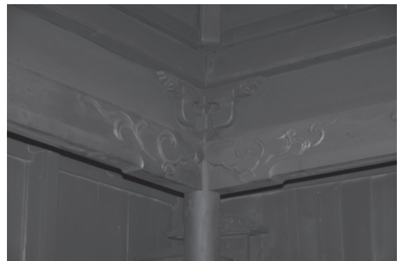
図 907 蓮華定院護摩堂内陣虹梁形頭貫・組物
