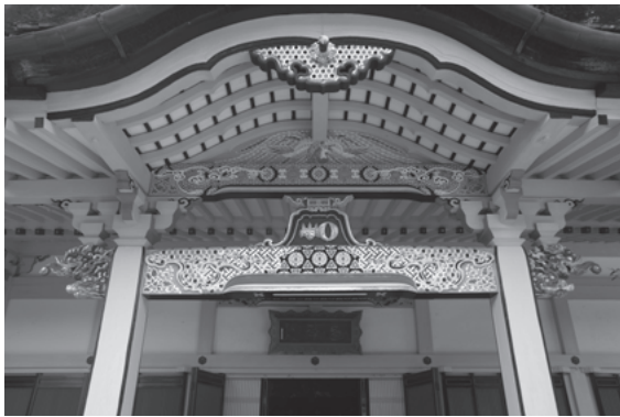
図 725 西南院本堂向拝軒下見上げ
