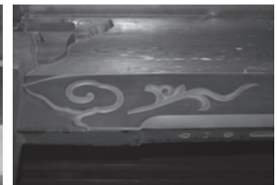
48 壇上加藍山王院拝殿 入側柱頭貫
