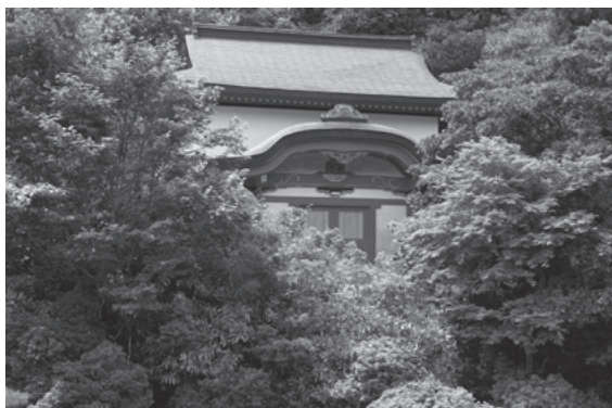
図 734 西南院経蔵遠景
