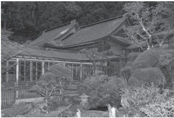
図 780 金剛三昧院本堂及び位牌堂正側面遠景
