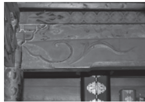
34 奥之院護摩堂 大師堂位牌棚正面頭貫
