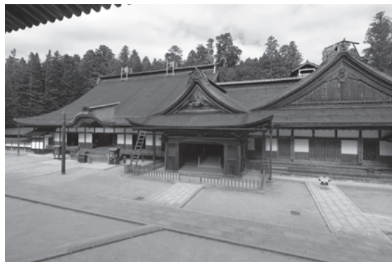
図 949 客殿・台所・玄関の複合屋根（金剛峯寺大主殿）
