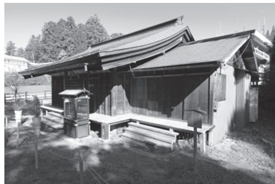
図 881 観音堂正側面 (南東より)
