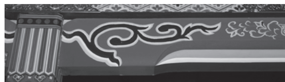
図 844 普賢院本堂南部内陣梁行中央間
