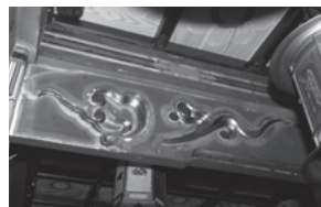
79 普賢院本堂 南部南入側通頭貫
