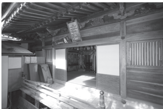
図 823 普賢院本堂北部側まわり
