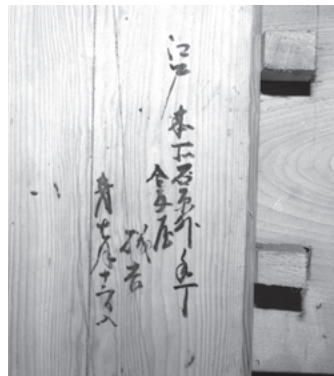
15 壇上加藍西塔天保五年(一八三四)棟札 総高1513mm 肩高1498mm 上幅235mm 下幅213mm 厚サ21mm 檜尖頭 釘穴なし
