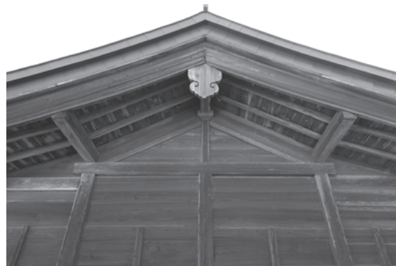
図 883 観音堂妻面架構見上げ
