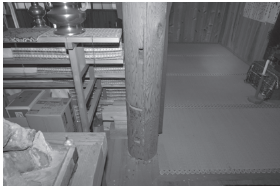
図 885 観音堂正面西側四天柱背面痕跡
