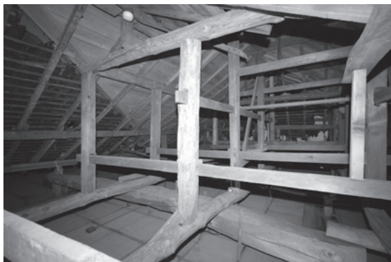
図 861 普門院本堂小屋組（中央部から南部をみる）
