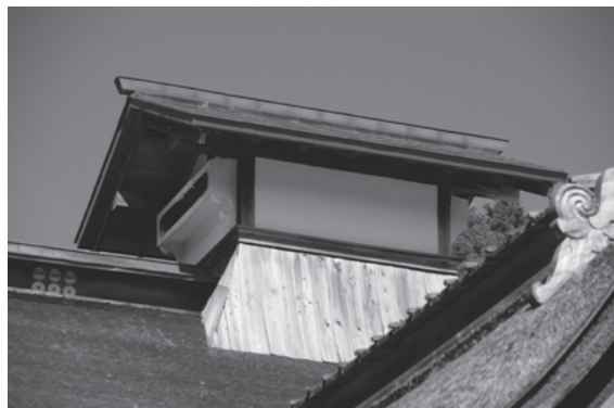
図 931 蓮華定院庫裏煙出し
