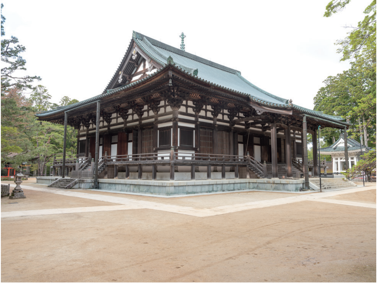
壇上加藍金堂 正側面
