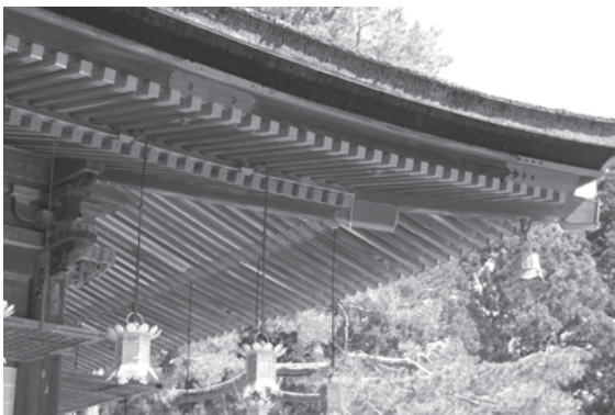
図946 鼻先を大きく造り出す飛檐隅木(壇上加藍御影堂)
