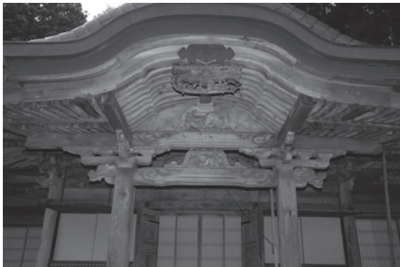
図 863 普門院本堂向扨軒まわり見上げ
