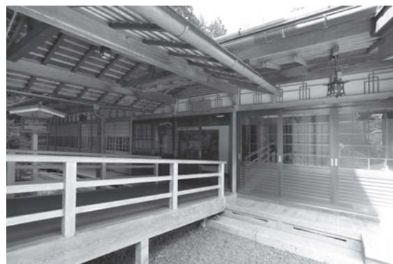
図 808 不動院書院廊下接続部(旧玄関)
