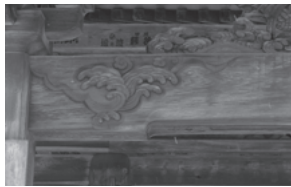
57 壇上加藍愛染堂 向拝頭貫南面
