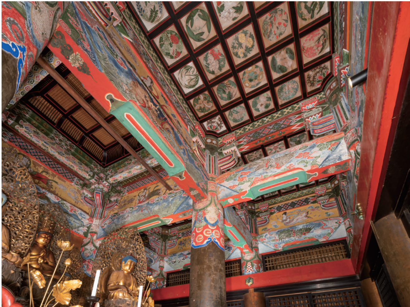
壇上加藍西塔 内陣見上げ
