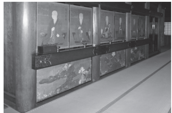
図947 奥行の深い腰長押による八祖棚(壇上加藍御影堂)
