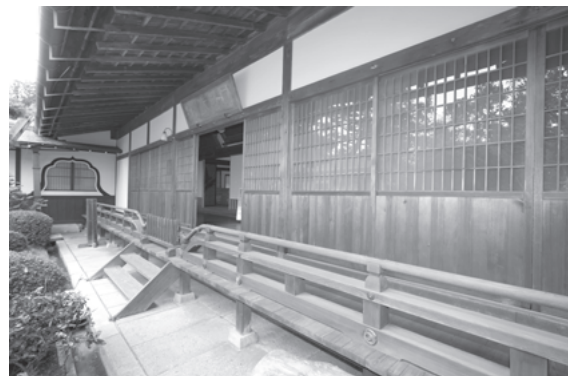
図 754 常喜院客殿正面側まわり
