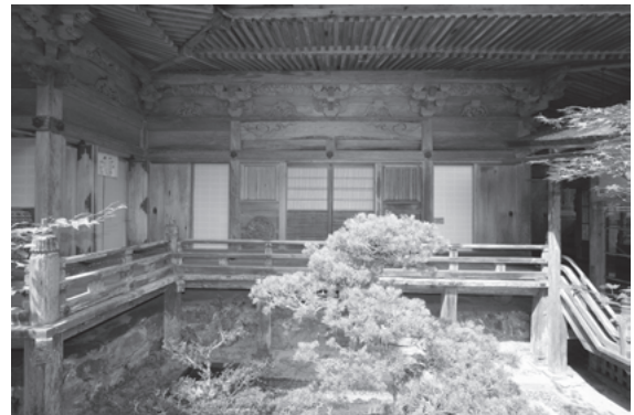
図 783 金剛三昧院本堂位牌堂正面側まわり
