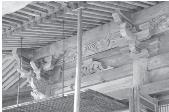
図 857 普門院本堂主体部北部正面軒下見上げ
