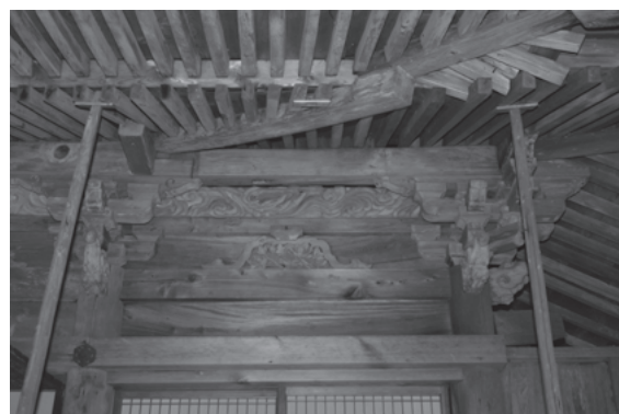
図 858 普門院本堂南部主体部正面南端間軒下見上げ
