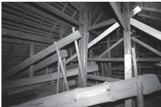
図 846 普賢院本堂中央部小屋組
