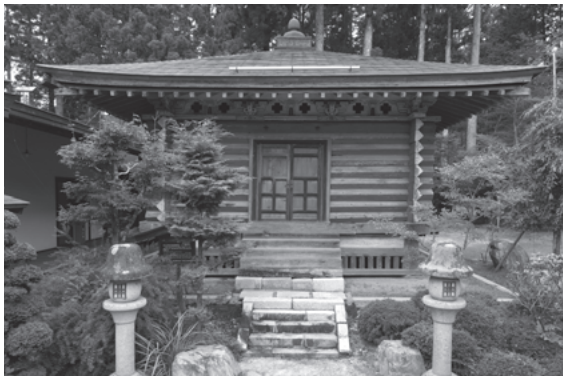
図 769 常喜院校倉正面
