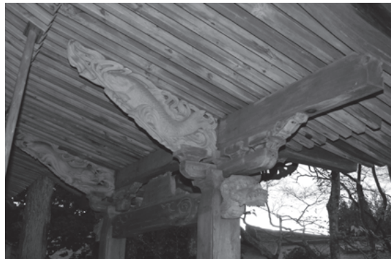
図 864 普門院本堂向扨手挟み
