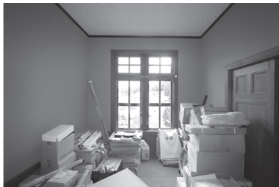
図 750 西南院洋館 2階東北室
