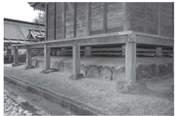
図943 縁下に納まる乱石積基壇(金剛峯寺真然堂)
