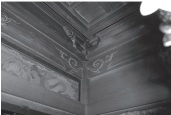
図 902 蓮華定院本堂内陣虹梁形頭貫・組物
