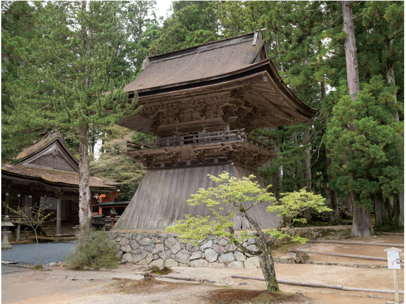
壇上加藍山王院鐘楼 正側面
