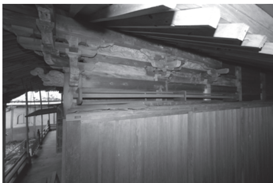
図 859 普門院本堂南面側まわり
