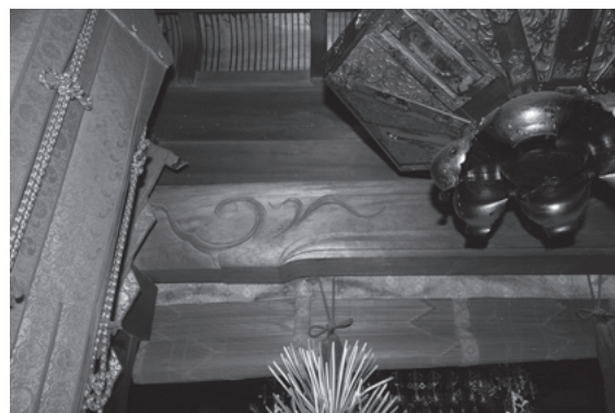
图 687 宝城院本堂外陣背面中央間虹梁形内法貫
