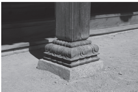
図 637 円通寺本堂向拝柱礎石・礎盤
