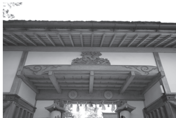
図 296 金剛峯寺会下門東正面虹梁形内法貫見上げ
