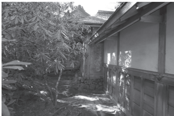
図268 金剛峯寺築地塀南部北端東面
