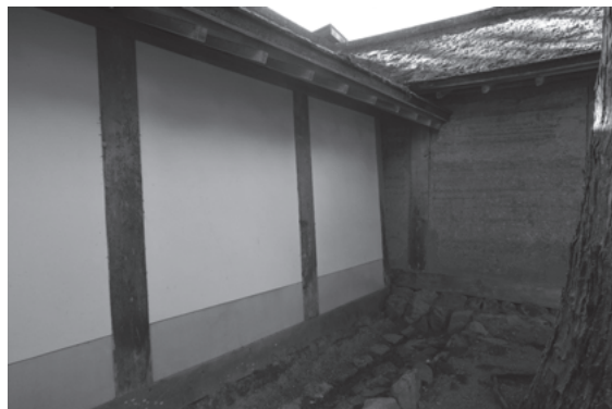
図 261 金剛峯寺かご堀西部西端築地堀接続部
