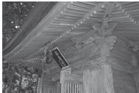
図 608 奥之院密厳堂軒下見上げ
