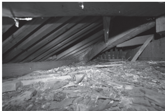
図 612 奥之院密厳堂小屋組、隅木棟札打ち付け
