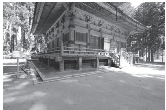
図 391 壇上加藍西塔初重側まわり
