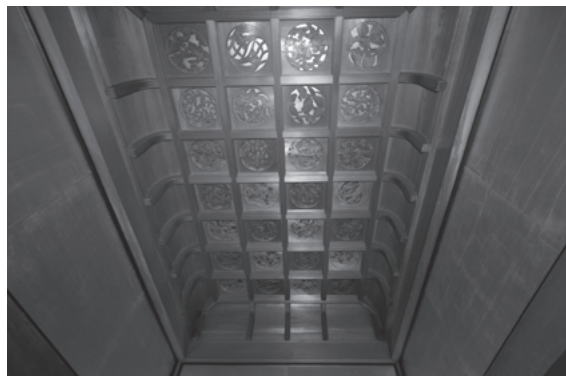
図 193 金剛峯寺大主殿上段の間上々段天井見上げ
