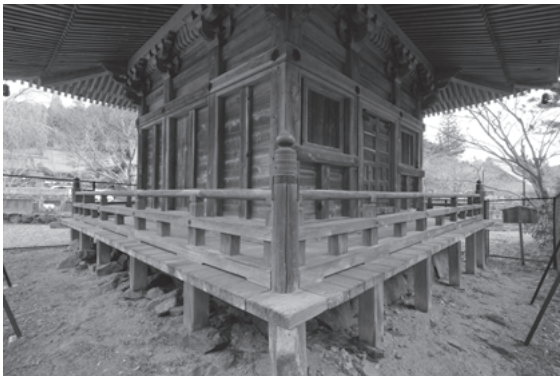
図 554 金輪塔初重背側面側まわり
