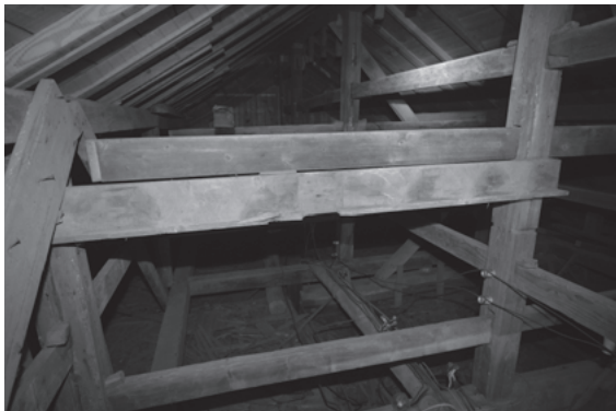
図 578 女人堂小屋組、襟輪欠き・釘彫りを施した長押転用材
