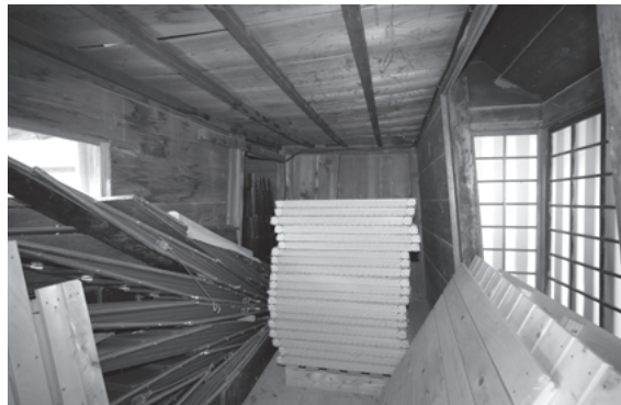
図 250 金剛峯寺かご堀東部西端部
