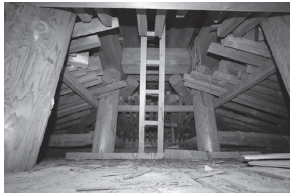
図 559 金輪塔小屋組四天柱納まり
