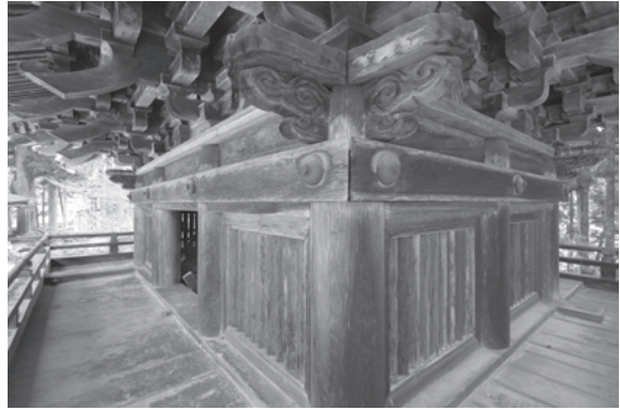
図 288 金剛峯寺鐘楼上層側まわり
