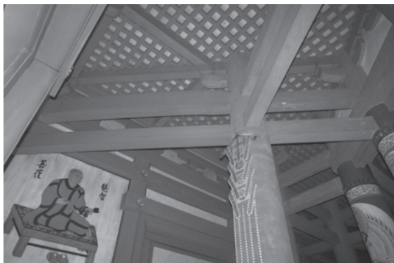
図 378 壇上加藍根本大塔隅行架構見上げ
