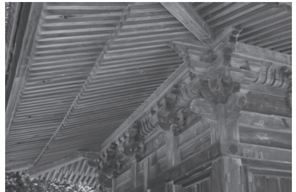
図 555 金輪塔初重軒下見上げ
