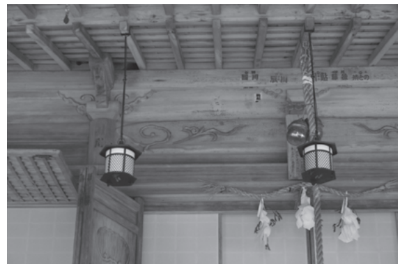
図 442 壇上加藍山王院拝殿正面中央間虹梁形頭貫
