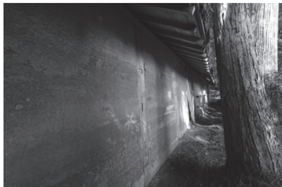
図 273 金剛峯寺築地塀北部当面柱痕跡 (北から 11 間目)
