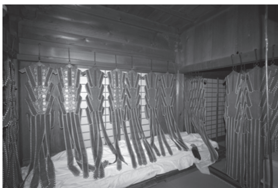
図 416 壇上加藍御影堂背面突出部西脇間物置
