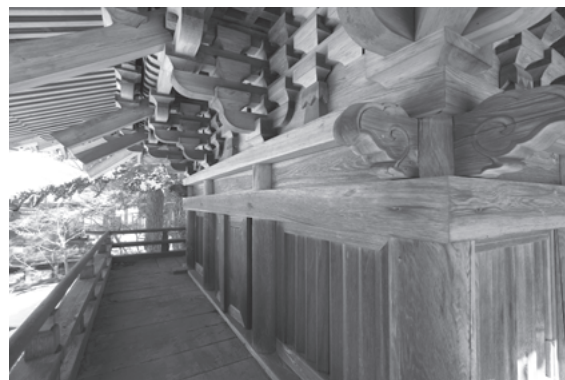
図 516 勸学院鐘楼上層側まわり
