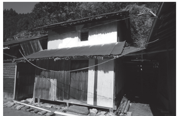
図 59 下筒香の杉皮葺鉄板葺の土蔵 (No. 528)
