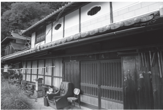
図48 杖ヶ藪の鉄板葺民家 (No. 436)
