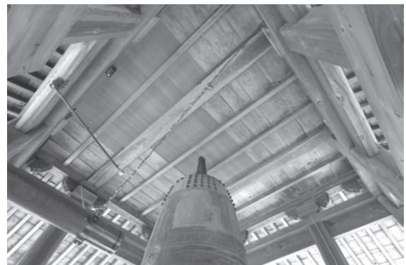
図 341 六時鐘楼天井見上げ
