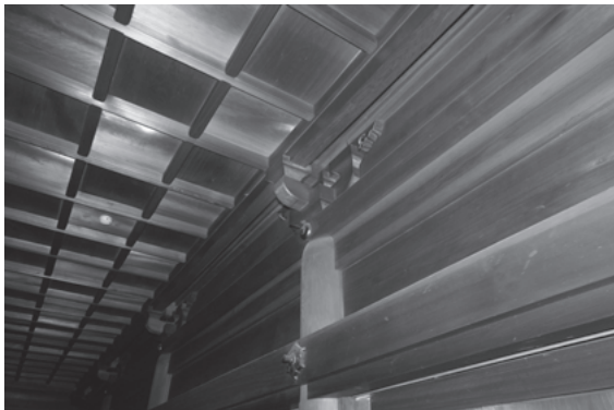
図414 壇上加藍御影堂外陣組物
