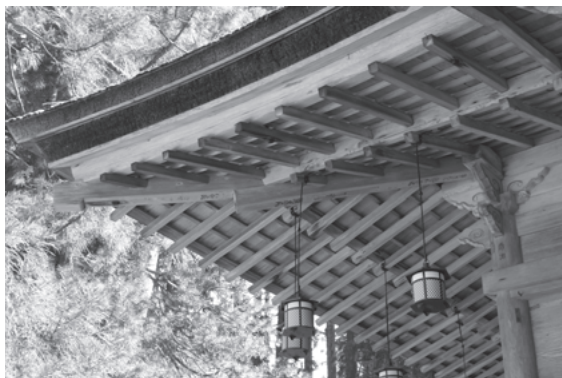
図 443 壇上加藍山王院拝殿隅木
