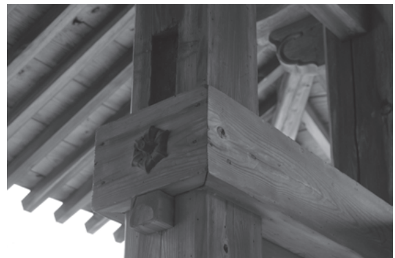
図 343 六時鐘楼側柱内法長押上の胴差痕跡
