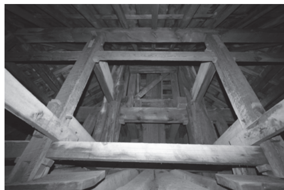
図 401 壇上加藍西塔上重架構
