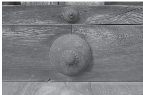
図 399 壇上加藍西塔目長押釘隠し
