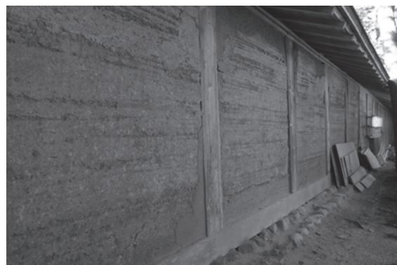
図 263 金剛峯寺築地塀南部南寄り東面
