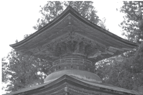
図 557 金輪塔上重軒まわり見上げ
