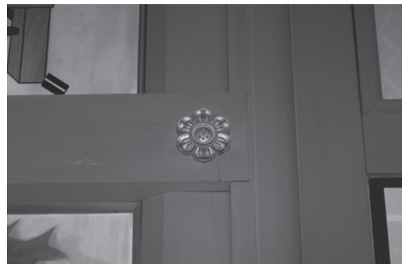
図 379 壇上加藍根本大塔釘隠し
