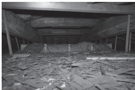
図 238 金剛峯寺護摩堂小屋組、棟札打ち付け状況
