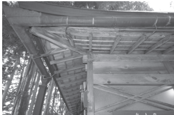
図 566 女人堂正面軒まわり見上げ
