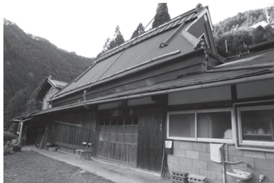
図47 杖ヶ藪の茅葺民家 (No. 403)
