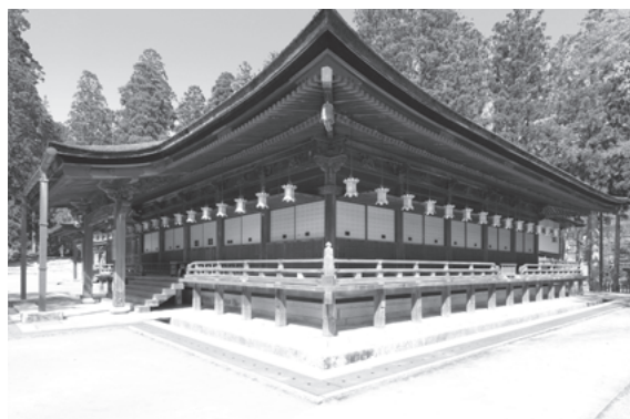
図 406 壇上加藍御影堂側まわり
