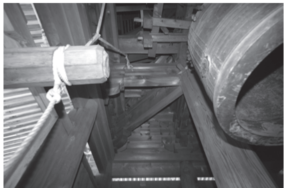
図 462 壇上加藍山王院鐘楼上層架構見上げ
