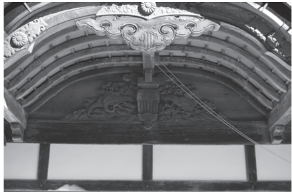
図 204 金剛峯寺大主殿客殿南面軒唐破風
