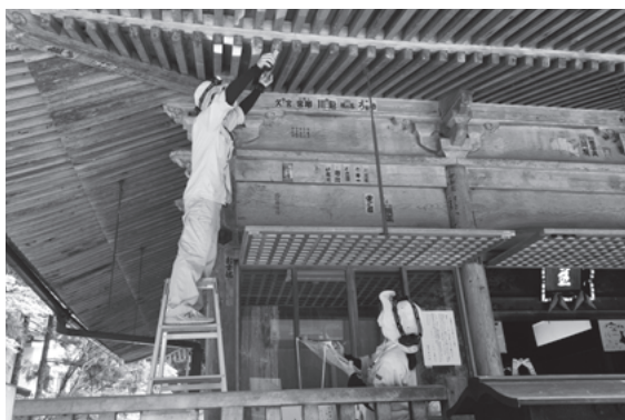
図2 実測調査風景
