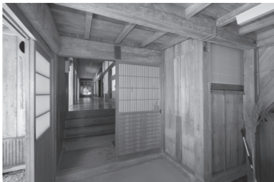
図 657 円通寺会下1階庫裏接続部
