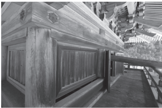
図 457 壇上加藍山王院鐘楼上層側まわり
