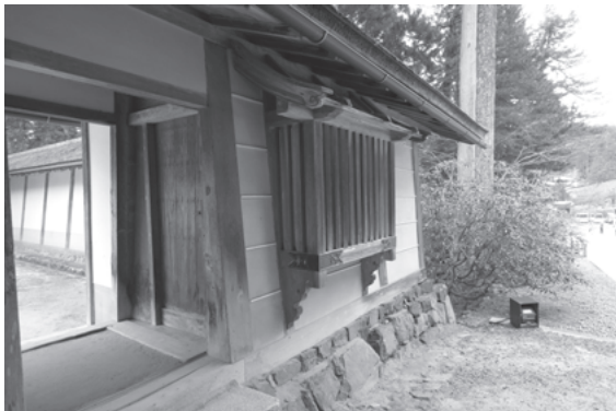
図 249 金剛峯寺かご堀東部西端出窓
