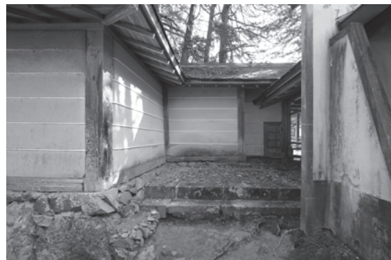
図269 金剛峯寺築地塀北部南端渡廊下接続部
