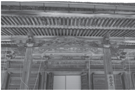
図 485 壇上加藍大会堂向拝軒下見上げ
