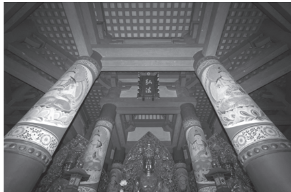
図381 壇上加藍根本大塔内陣見上げ
