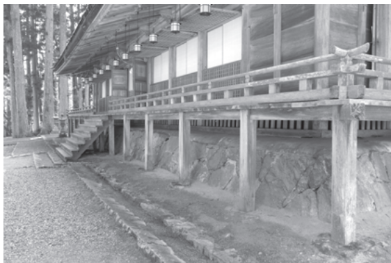
図 441 壇上加藍山王院拝殿基壇・縁まわり
