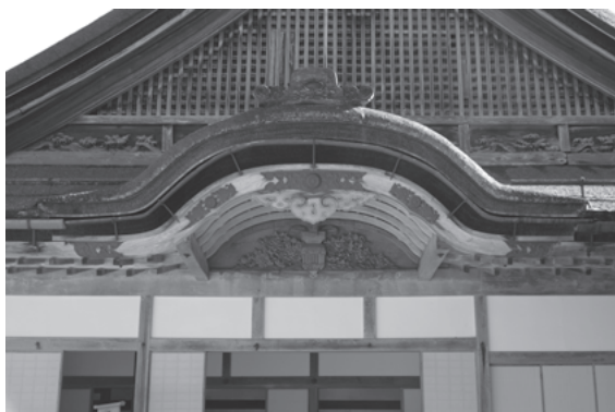
図 205 金剛峯寺大主殿西面軒唐破風
