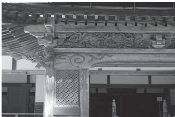
図 207 金剛峯寺大主殿大玄関虹梁形頭貫・組物
