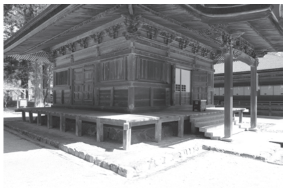
図 431 壇上加藍准胝堂正側面側まわり
