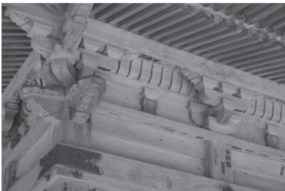
図 392 壇上加藍西塔初重組物
