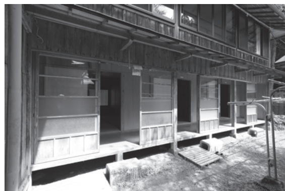
図 656 円通寺会下南北棟1階
