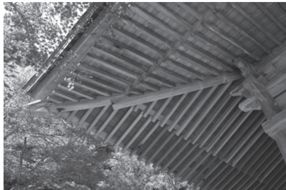
図 631 円通寺本堂隅木
