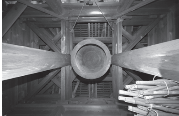
図 294 金剛峯寺鐘楼架構見上げ
