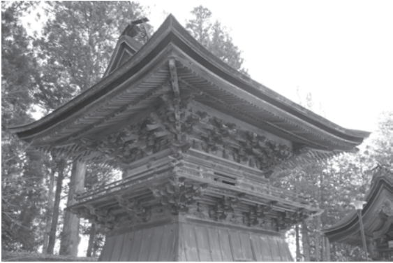
図 287 金剛峯寺鐘楼見上げ
