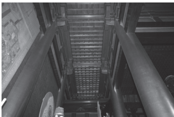
図 367 壇上加藍金堂内陣仏壇上天井
