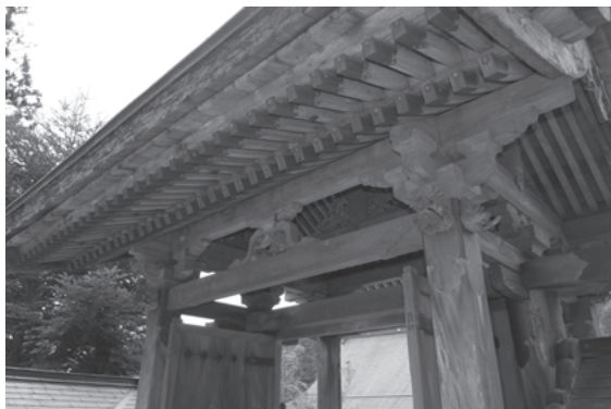
図 546 徳川家霊台表門軒下見上げ
