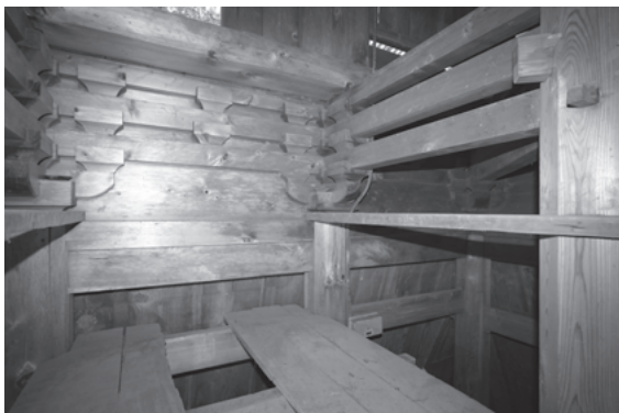
図 461 壇上加藍山王院鐘楼上層内部
