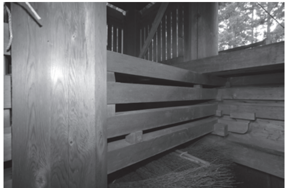
図 292 金剛峯寺鐘楼腰組高さ内部
