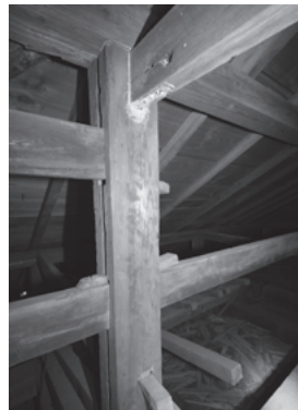
図 579 女人堂小屋組、面取り・板決りを施した柱転用材
