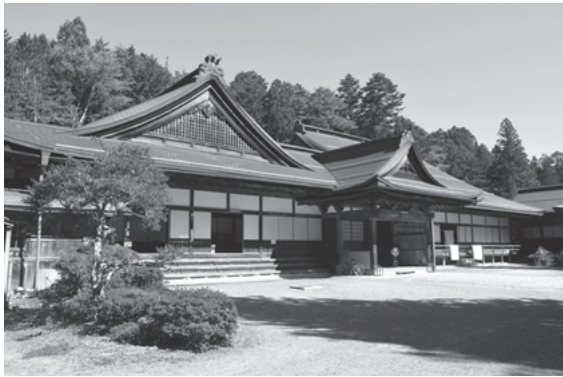
図 82 龍光院客殿・庫裏・玄関 (No. 7-4～6)
