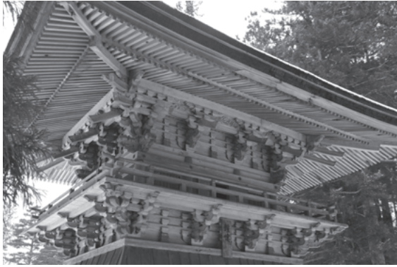
図 455 壇上加藍山王院鐘楼見上げ
