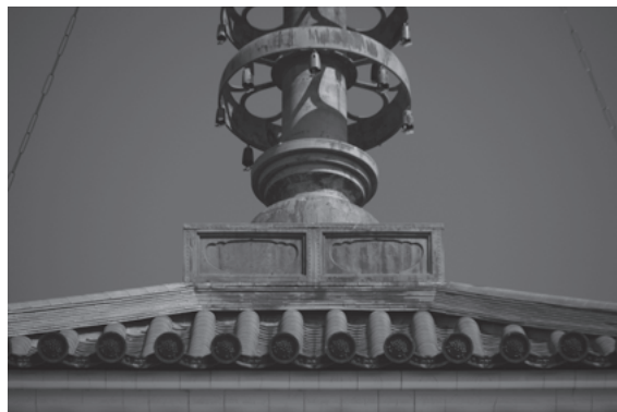
図 386 壇上加藍根本大塔露盤
