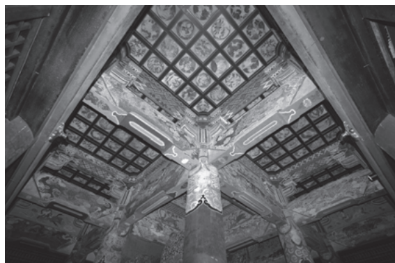
図 397 壇上加藍西塔内陣架構見上げ
