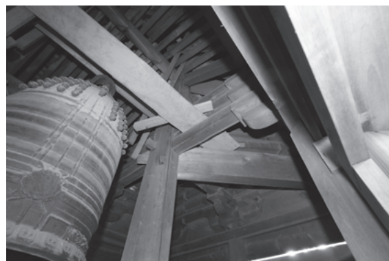
図 521 勸学院鐘楼上層架構見上げ
