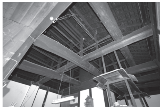
図 649 円通寺庫裏庫裏部架構見上げ
