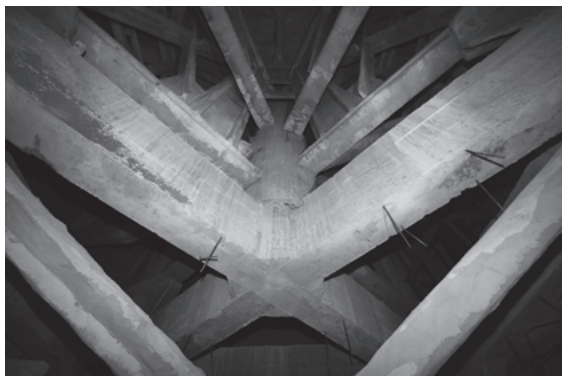
図 383 壇上加藍根本大塔鉄骨鉄筋コンクリート造躯体
