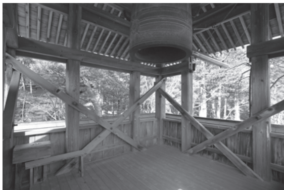
図 340 六時鐘楼内部
