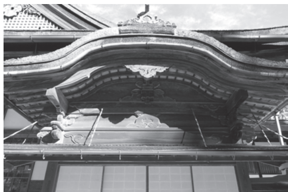
図 209 金剛峯寺大主殿小玄関軒まわり見上げ
