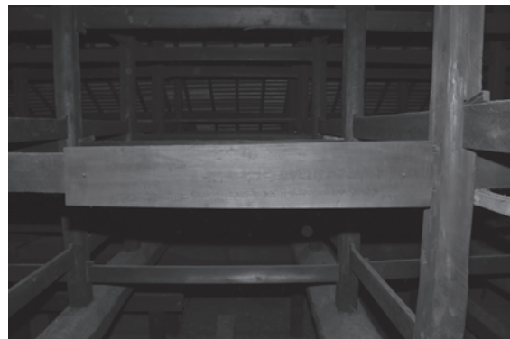
図 197 金剛峯寺大主殿小屋組棟札打ち付け状況
