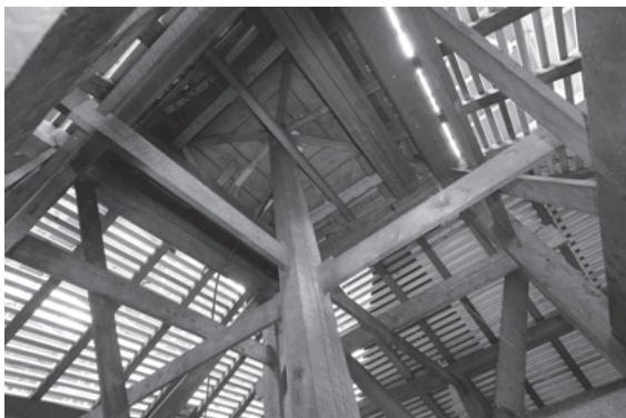
図 421 壇上加藍御影堂小屋組宝珠束見上げ
