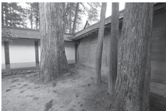
図 262 金剛峯寺築地塀南部南端かご塀接続部
