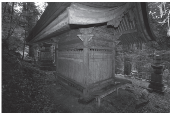
図 616 奥之院井伊直政霊屋背側面
