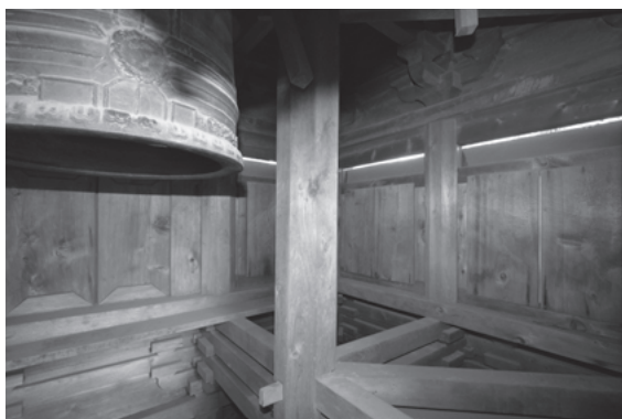
図 520 勸学院鐘楼上層内部
