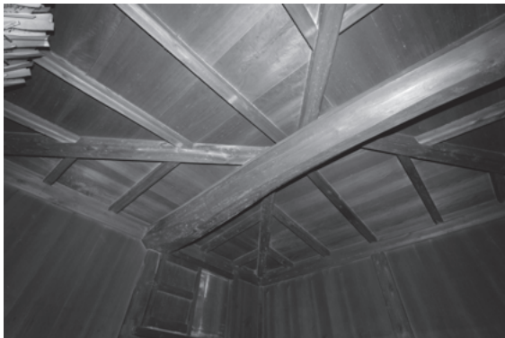
図 666 円通寺求聞持堂架構・天井見上げ
