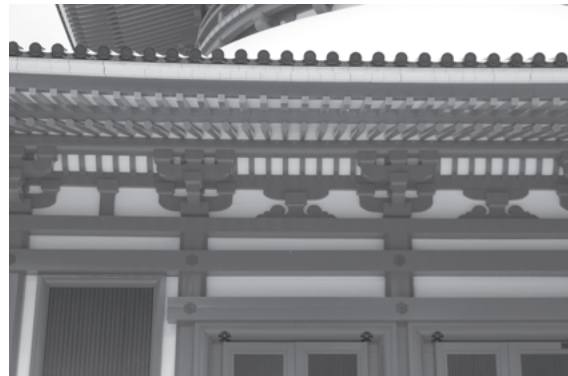
図 375 壇上伽藍根本大塔初重組物・中備幕股
