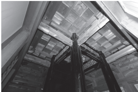
図 558 金輪塔初重架構・天井見上げ
