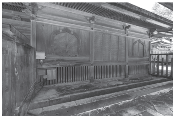
図 407 壇上加藍御影堂背面側まわり
