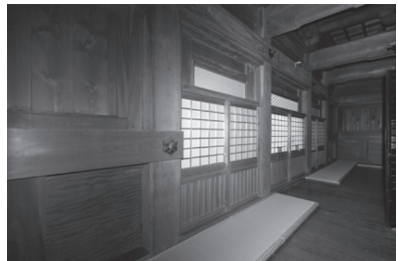
図 395 壇上加藍西塔側通り
