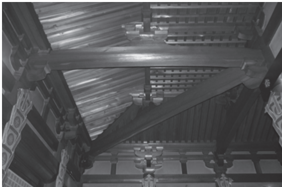
図 363 壇上加藍金堂外陣架構見上げ
