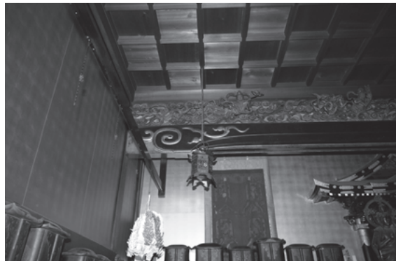
図 186 金剛峯寺大主殿持仏堂虹梁形内法貫
