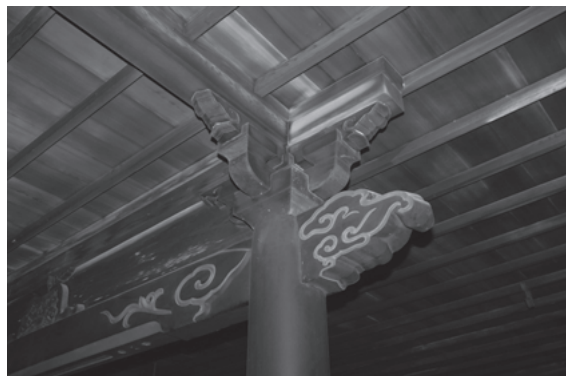
図 447 壇上加藍山王院拝殿入側柱頭貫木鼻・組物
