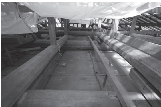
図 423 壇上加藍御影堂内々陣天井裏内々陣天井裏
