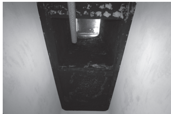
図 202 金剛峯寺大主殿煙抜き見上げ
