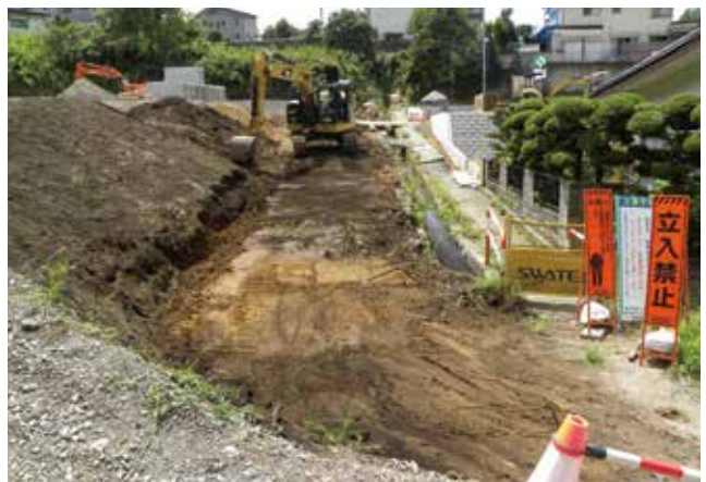
市道拡幅部分 掘削後 (北から)
