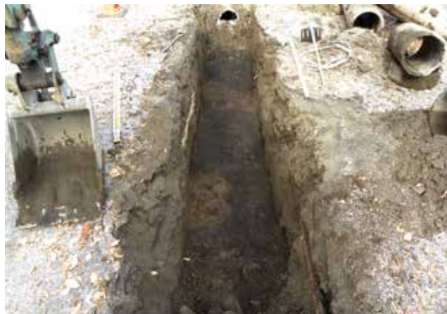
掘削工事北端（南から）
