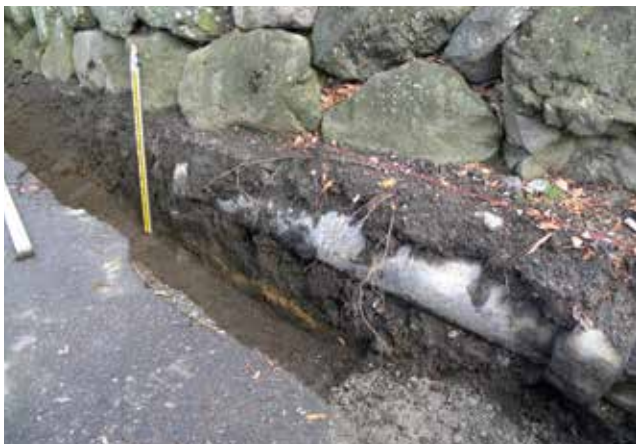
石垣下に埋設されていた既設管（南西から）
