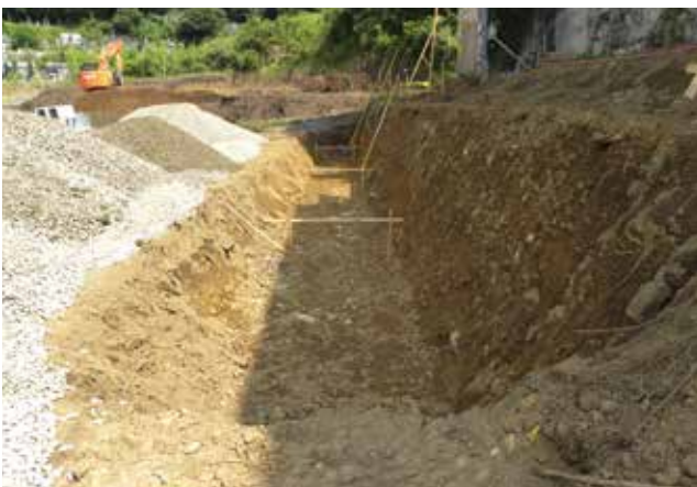
第2駐車場南壁部分 掘削後 (西から)
