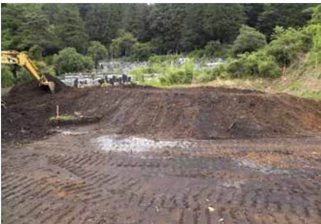
工事立会い 黒耀石原石採集時の状況 (西から)
