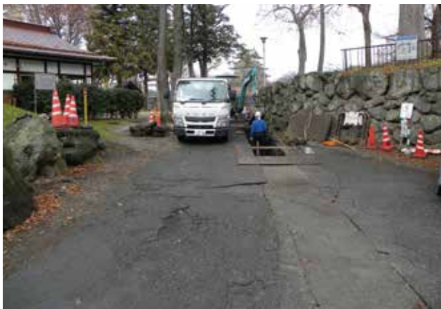
高島城跡本丸内 掘削工事の様子（南から）
