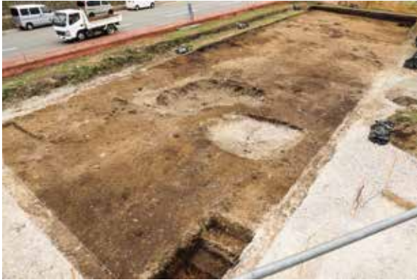
写真 24 1区表土除去状況遠景（南東方向から）
