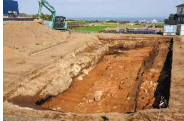
写真 41 2区表土除去状況（南西方向から）
