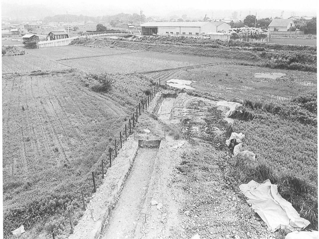
c. 試掘 東その3(上)、東その2(下)トレンチ全景(北から)
