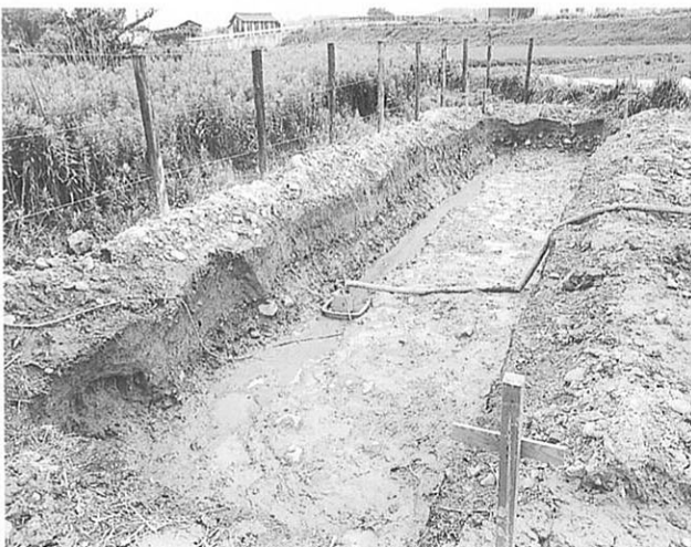
d. 試掘 東その3トレンチ全景(北から)
