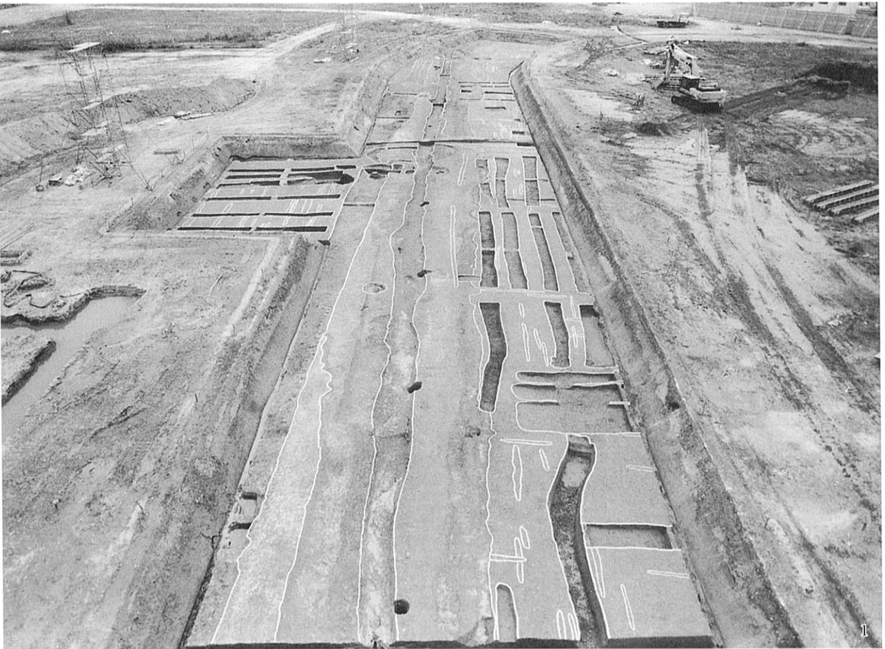
1. 河川1掘削前1面全景（北から）
