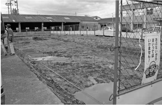
1 1区調査前状況(東から)
