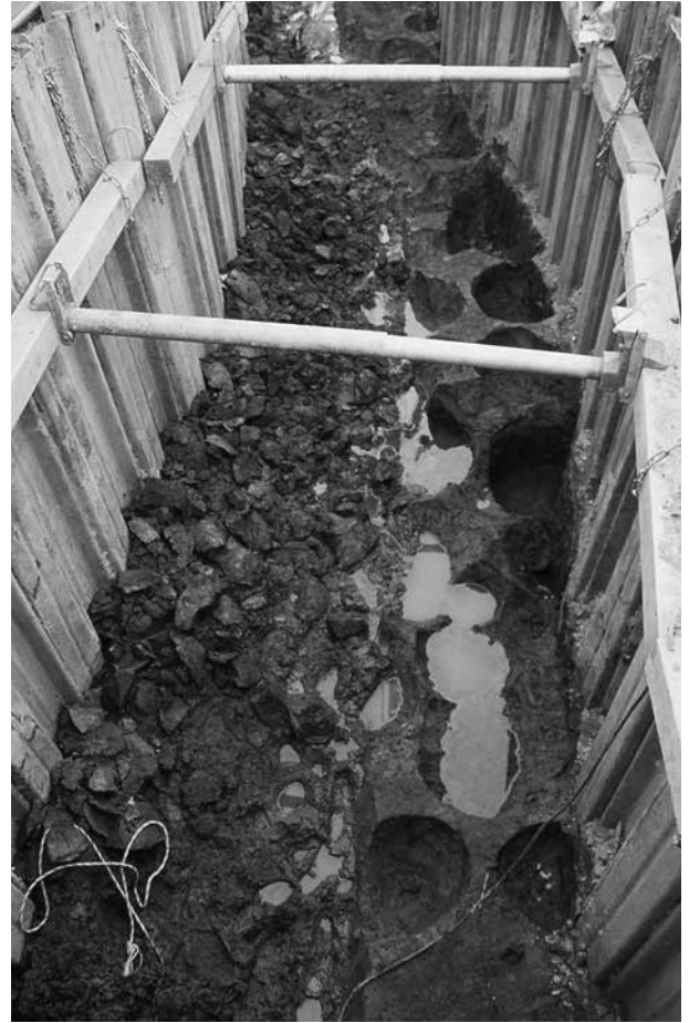
2 立会調査状況（南西から）
