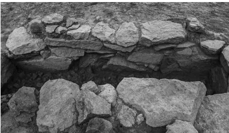
5 桑山4号墳竪穴式石室2東壁（西から）
