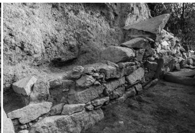
3 桑山1号墳玄室右側壁（北から）
