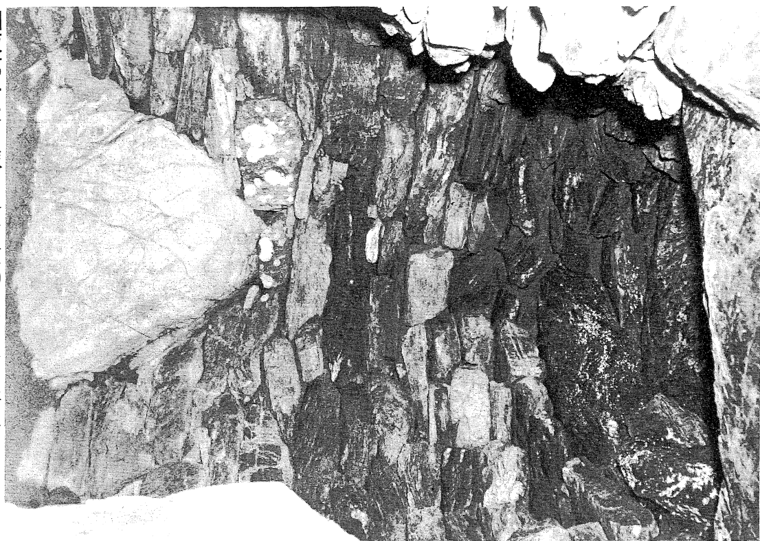
後室奥壁の構築状況
