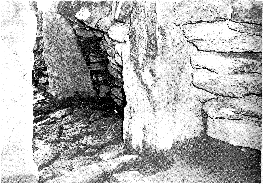
後室、前室の西壁側構築状況
