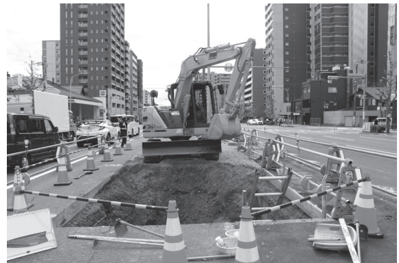
図15 2区掘削状況 (北から)
