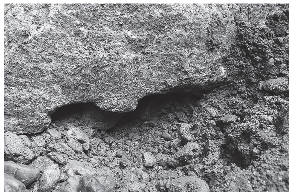
図12 矢穴（南西から）
