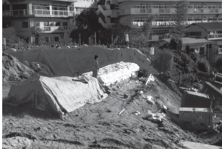
第 33 図 土塀移築作業の様子
