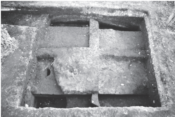
西トレンチ 1 調査終了状況 (北から)
