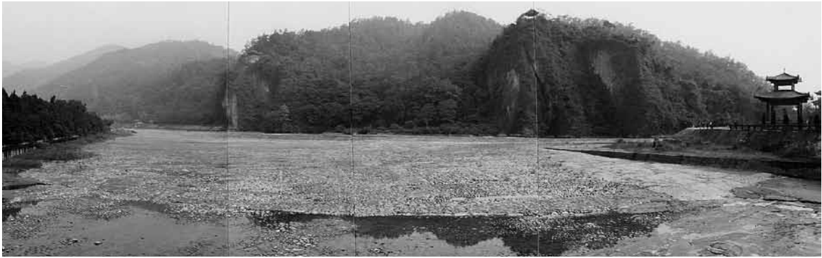
写真14 飛沙堰 全景（西南から）
