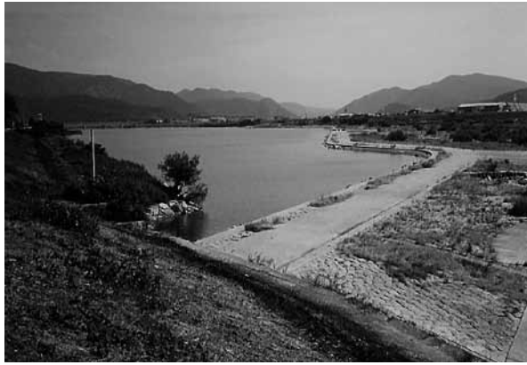
写真11 吉井堰 取水口付近（西南から）
