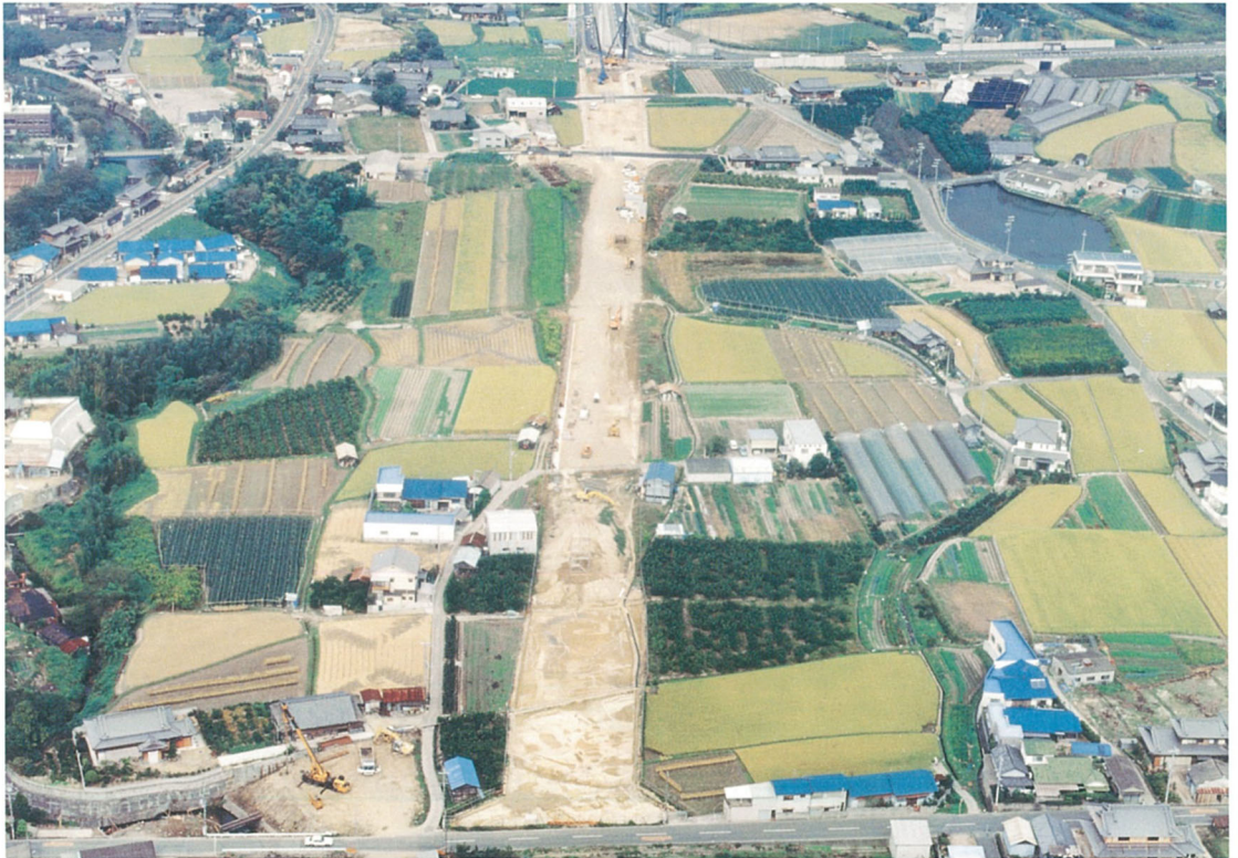
調査地全景（Sより）
