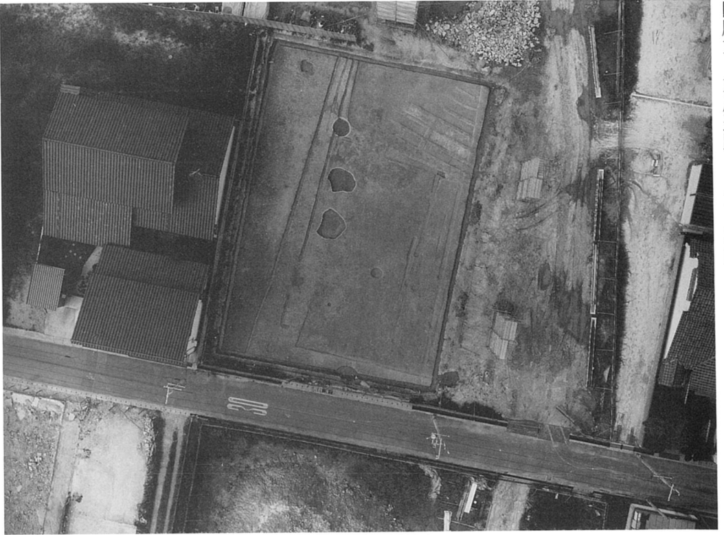
5-34区全景航空写真（上が西北：S = 1/500）
