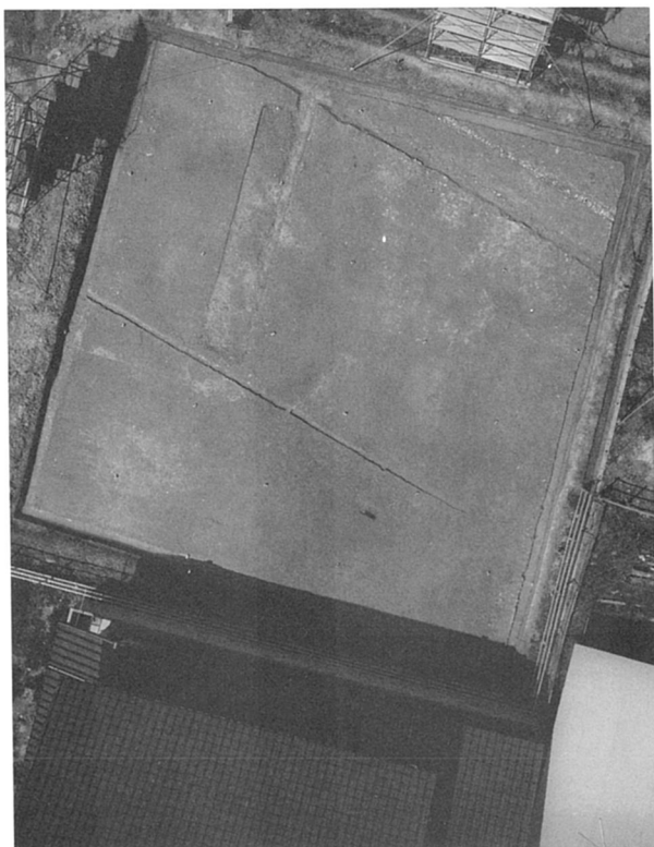
5-46区全景航空写真(上が西北 S = 1/500)
