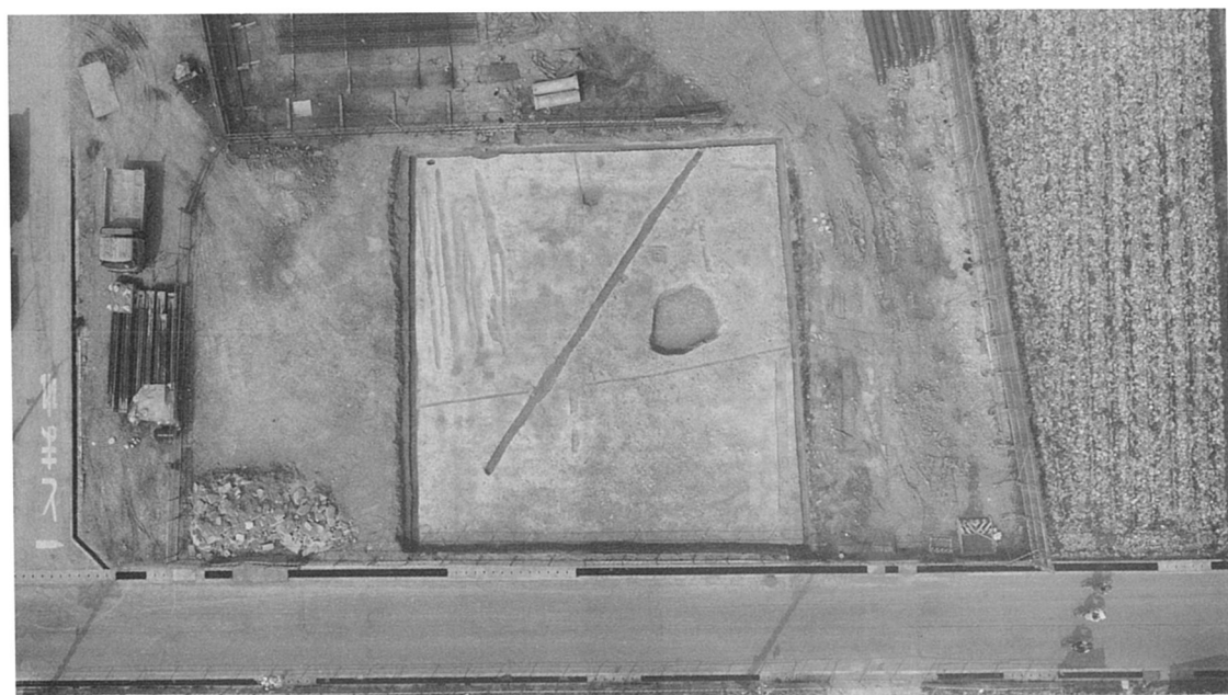
5-47区全景航空写真（上が西北：S = 1/500）
