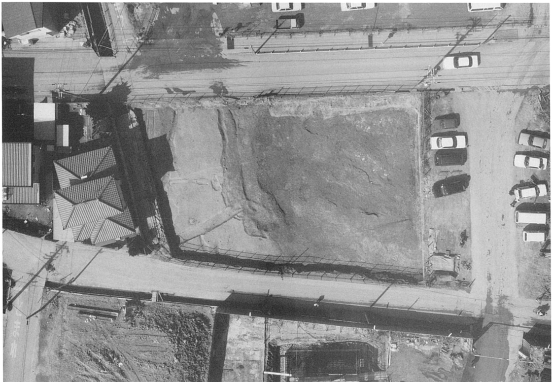
5-59区全景航空写真（上が西北：S = 1/500）
