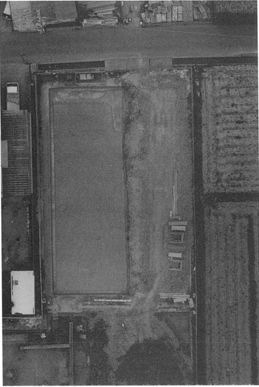
5-5区全景航空写真 (上が西北: S = 1/250)
