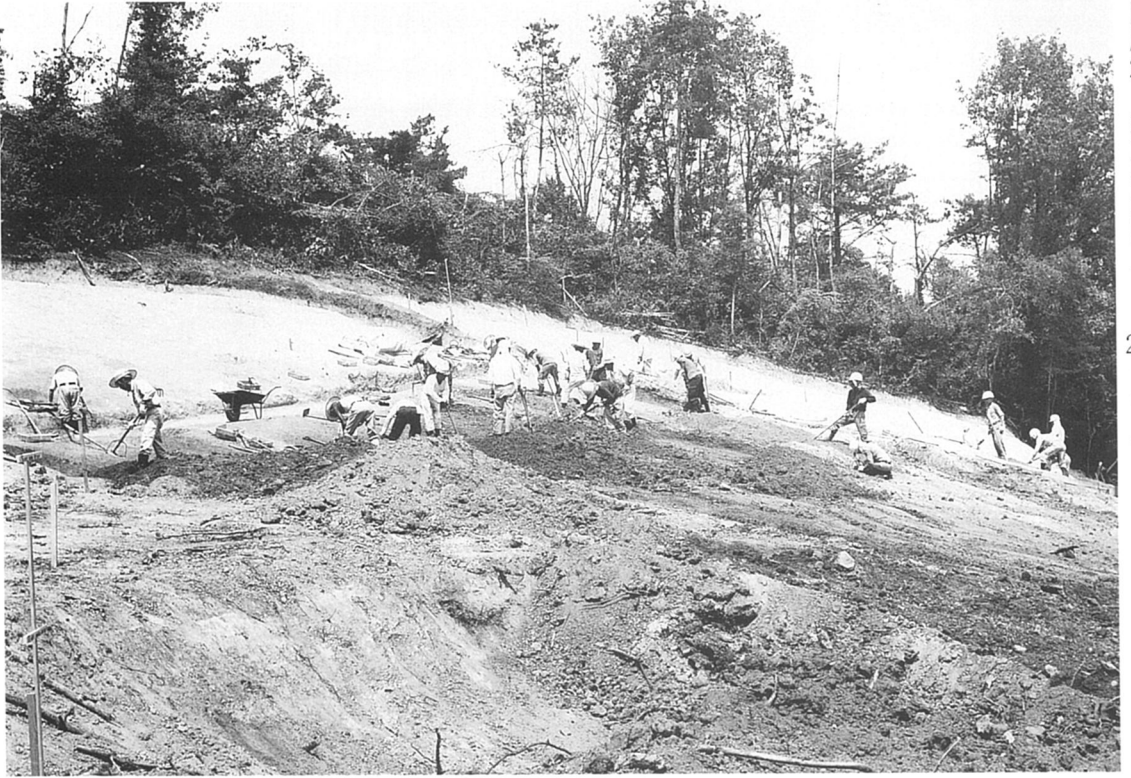
a. 掘削状況 (南西から)
