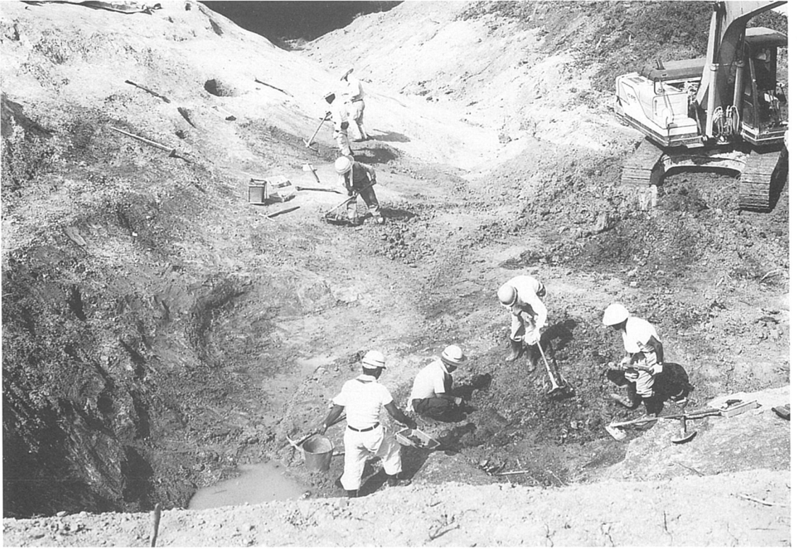
a. 谷底掘削状況（南西から）
