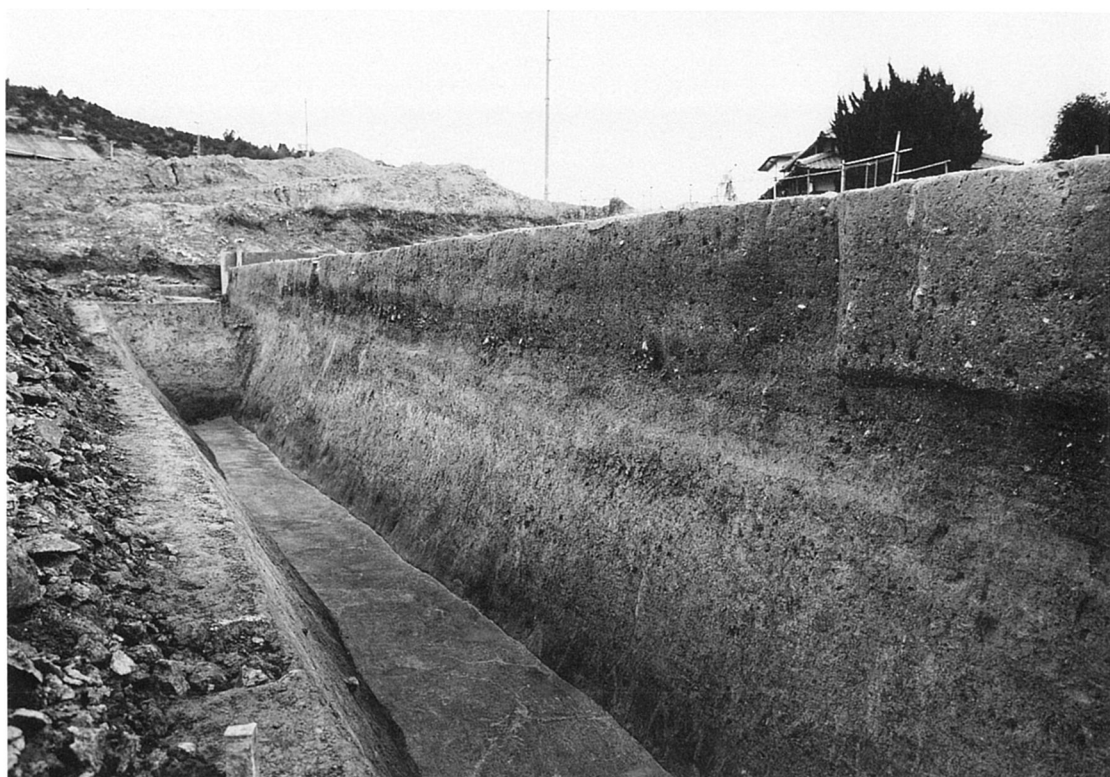
下層確認トレンチ及び第2～第10層土層断面（南西から）
