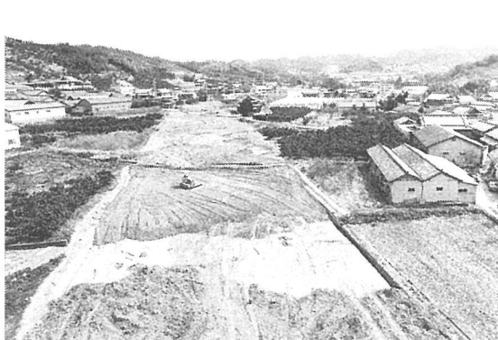
写真2 埋戻し状況
