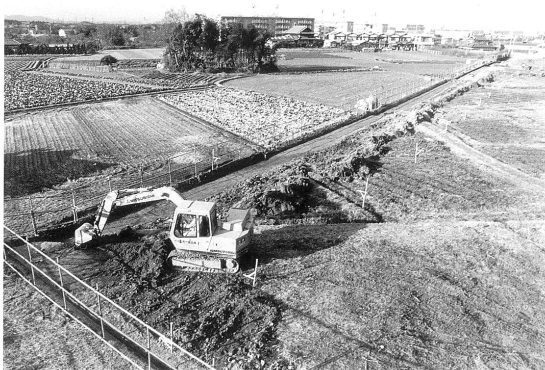
トレンチ掘削状況
