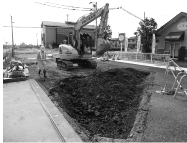
写真2 表土掘削作業
