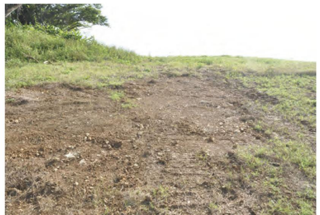
4号墓 埋め戻し完了状況
