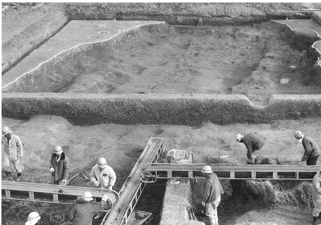
A-4区 611-00内 掘削状況
