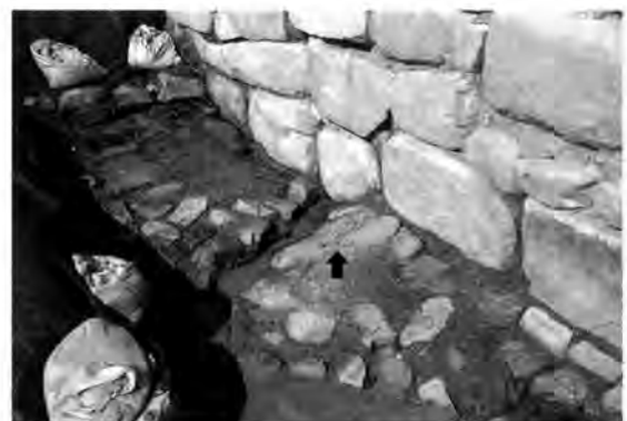
第13図版 第0水門排水位置
