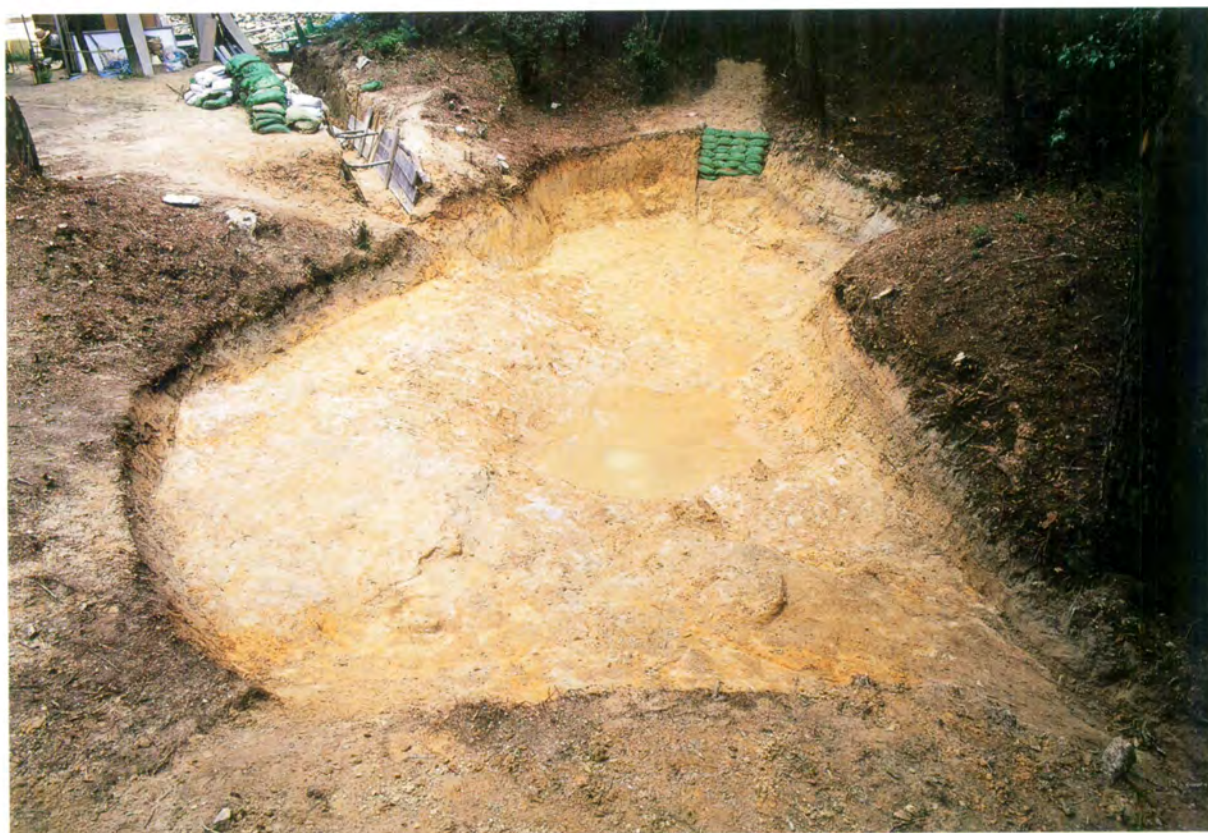
1. 第1水門 貯水池全景（東から）
