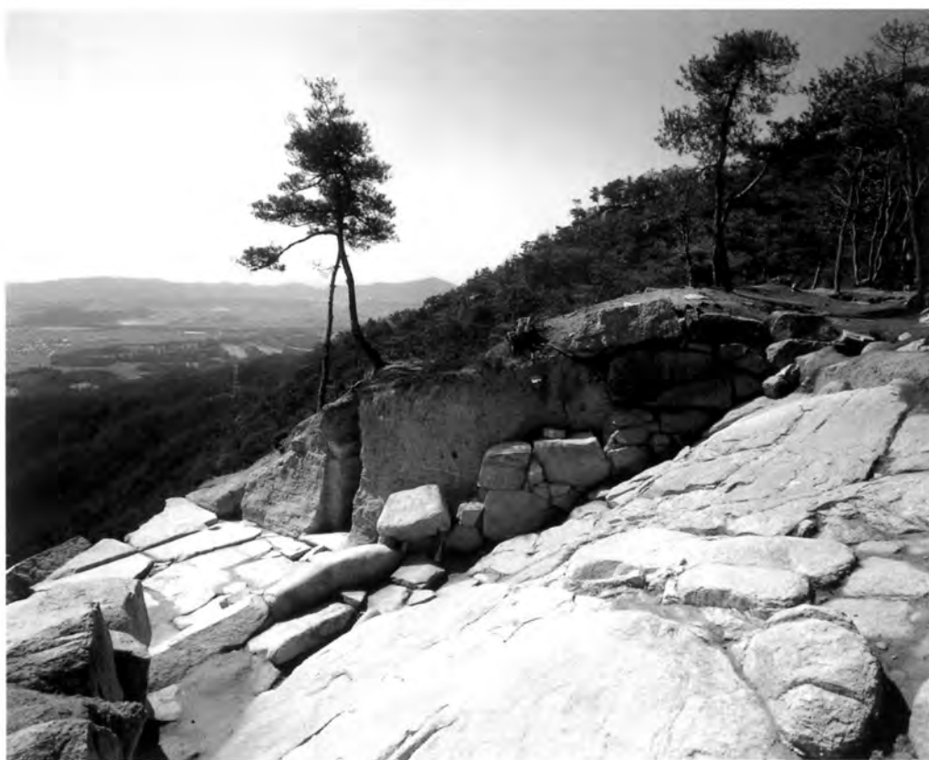
1. 東門 露岩と右側石垣（北から）
